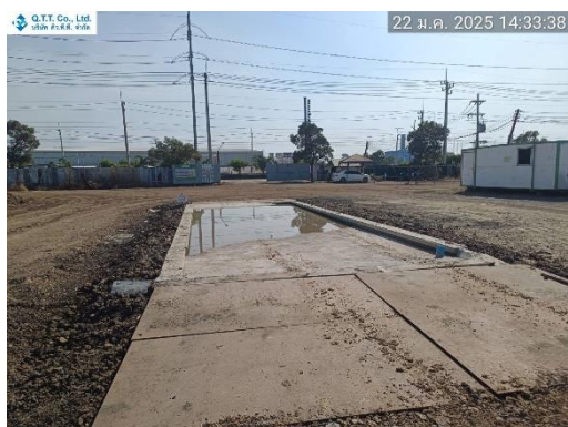
รูปที่ 4 พื้นที่ทำความสะอาดล้อรถ
