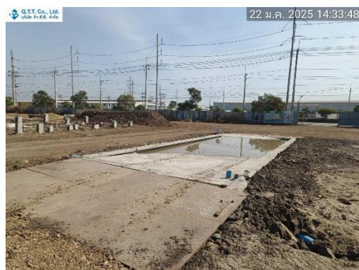
รูปที่ 4 พื้นที่ทำความสะอาดล้อรถ
