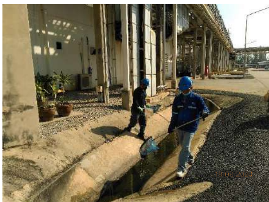
รูปที่ 2-10 การทำความสะอาดรางระบายน้ำฝน
