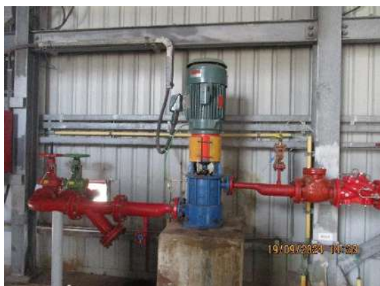
รูปที่ 2-18 เครื่องสูบน้ำรักษาแรงดัน (Jockey Pump)
