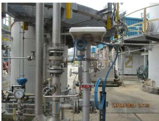
รูปที่ 2-23 อุปกรณ์ควบคุมการไหล อุปกรณ์วัดความดัน และอุณหภูมิสัญญาณเตือนและวาล์วนิรภัย
