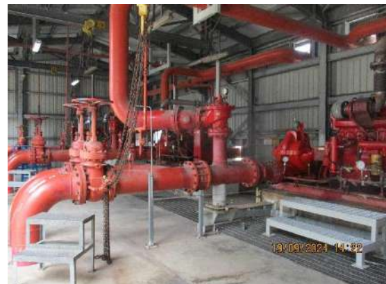
รูปที่ 2-8 เครื่องสูบน้ำแบบเครื่องยนต์ดีเซล
