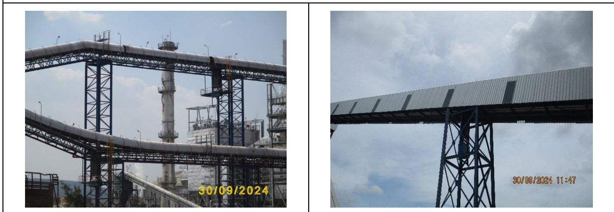
รูปที่ 14 ระบบสายพานลำเลียงแบบปิดครอบ
