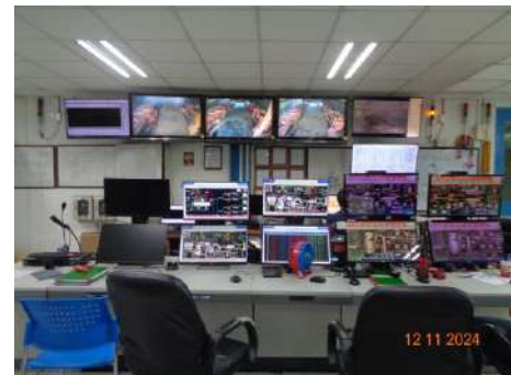
ภาพที่ 2.2-4 ระบบ DCS ควบคุมการทำงาน
