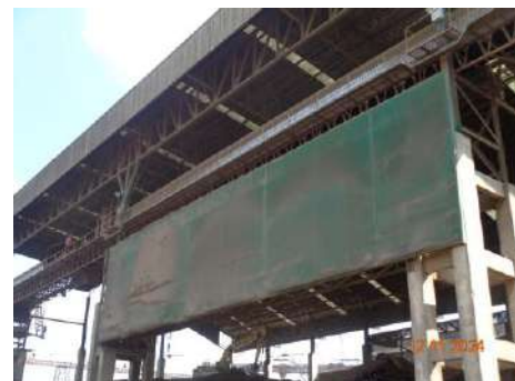
ภาพที่ 2.2-47 ตาข่ายป้องกันการฟุ้งกระจายละออง บริเวณอาคารเชื้อเพลิง (Bagasse House)
