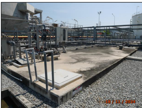
รูปที่ 2.15 บ่อปรับสภาพความเป็นกรด-ด่าง (Neutralization Pit)
