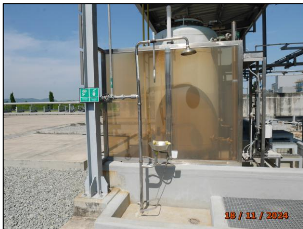
รูปที่ 2.28 อุปกรณ์ชำระล้างฉุกเฉิน
