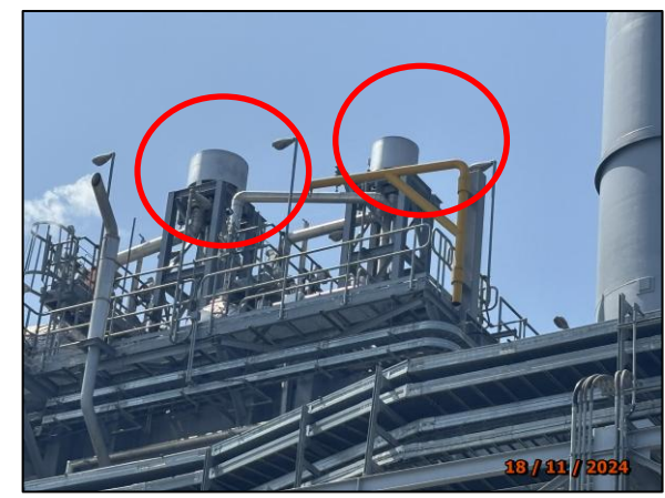
รูปที่ 2.9 อุปกรณ์ลดเสียง Silencer
