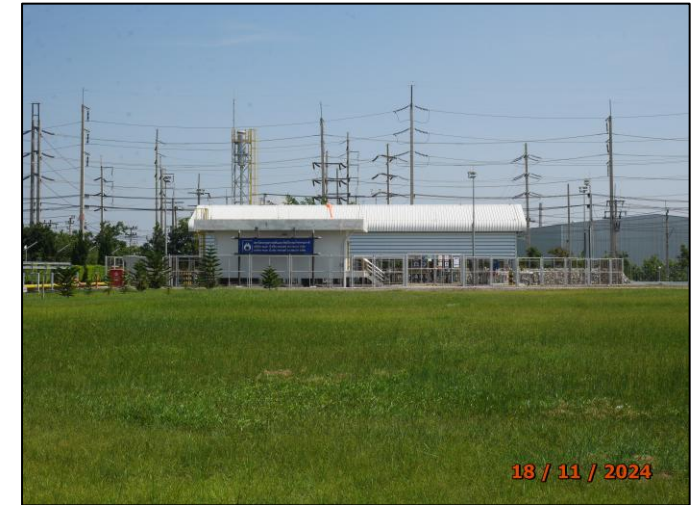
รูปที่ 2.43 สถานีควบคุมแรงดันและวัดปริมาณก๊าซธรรมชาติ
