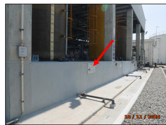
รูปที่ 2.36 คันคอนกรีตรอบถังเก็บสารเคมี
