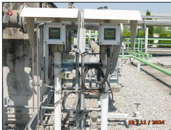
รูปที่ 2.13 เครื่องตรวจวัดคุณภาพน้ำอัตโนมัติ
