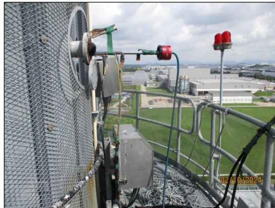
รูปที่ 3.1 การเก็บตัวอย่างคุณภาพอากาศในปล่องระบาย บริเวณ ปล่องหน่วยผลิตไอน้ำ HRSG 31
