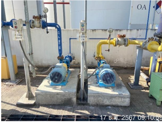
รูปถ่ายที่ 3.2-7 : เครื่องจักรติดแน่นบนแท่นคอนกรีต
