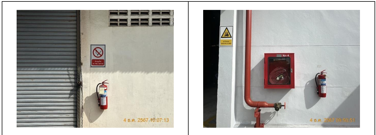
รูปถ่ายที่ 3.2-36 : อุปกรณ์ดับเพลิงแบบมือถือ
