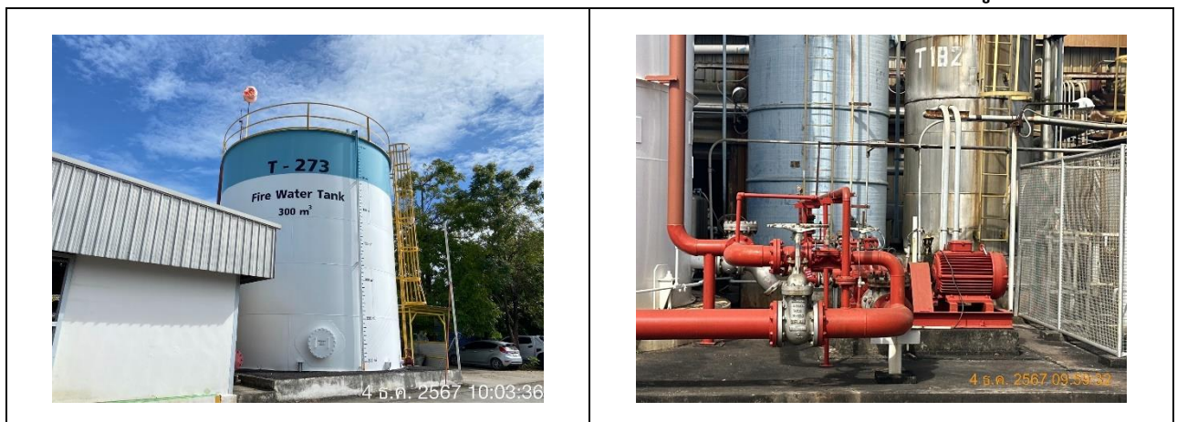
รูปถ่ายที่ 3.2-39 : ถังเก็บสำรองน้ำดับเพลิง ขนาด 300 ลูกบาศก์เมตร
