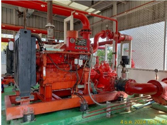
รูปถ่ายที่ 3.2-41 : เครื่องสูบน้ำดับเพลิงขนาด 375 ลูกบาศก์เมตร/ชั่วโมง
