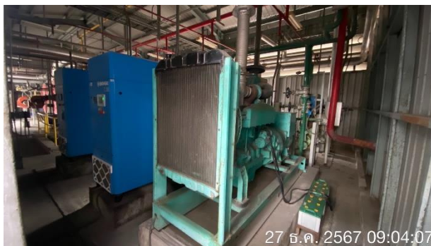
รูปถ่ายที่ 3.2-11 : เครื่องกำเนิดไฟฟ้าสำรอง
