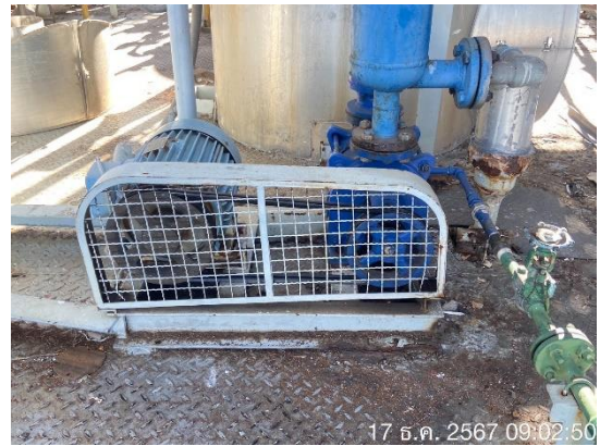
รูปถ่ายที่ 3.2-2 : Vacuum pump สำหรับดูดฝุ่นของ PA
