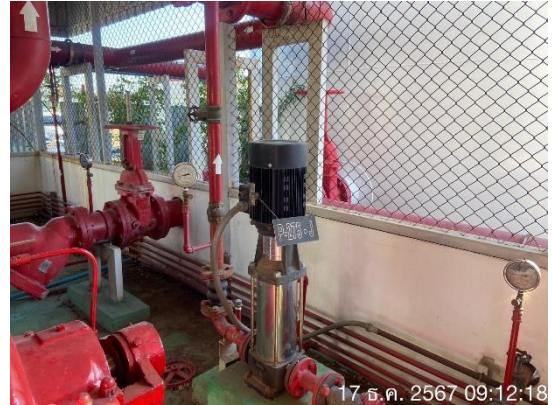
รูปถ่ายที่ 3.2-42 : ปั๊มแรงดันสูง
