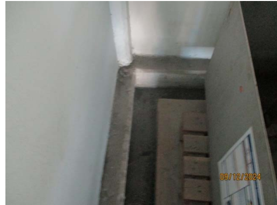
รูปที่ 3.1-1 (รูปที่ 20) รางระบายรวบรวมน้ำเสีย ภายในอาคารเก็บกากของเสีย)
