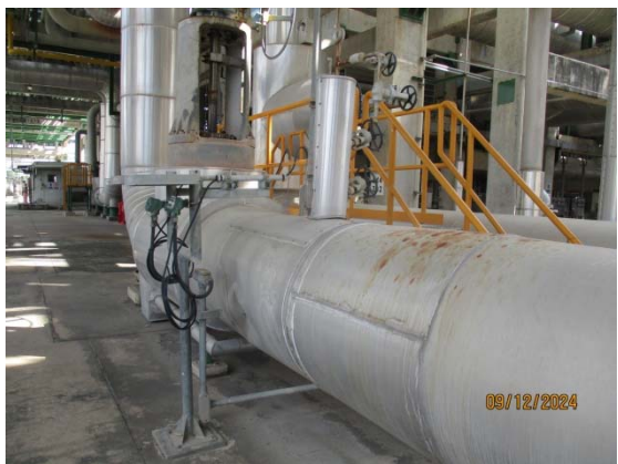
รูปที่ 3.1-1 (รูปที่ 27 ติดตั้งวัสดุดูดซับเสียง)
