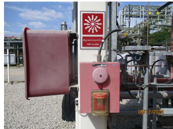
รูปที่ 3.1-1 (รูปที่ 58 Manual Fire Alarm)
