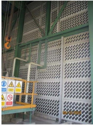
รูปที่ 3.1-1 (รูปที่ 43 การติดตั้งผนังกันเสียง บริเวณ Decoke Air Compressor)
