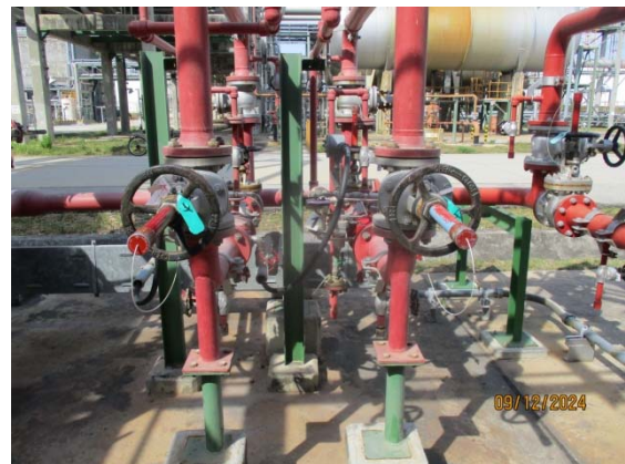
รูปที่ 3.1-1 (รูปที่ 52 Deluge Valve System)
