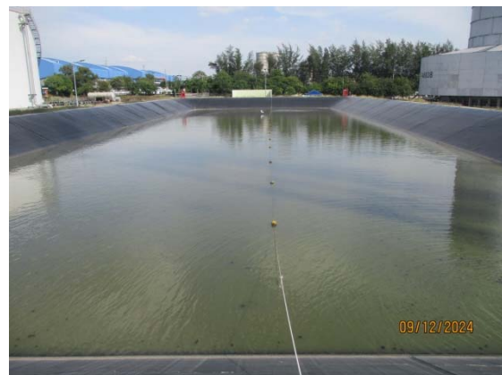
รูปที่ 3.1-1 (รูปที่ 12 บ่อพักน้ำทั้งหมด 1,200 ลบ.ม.)
