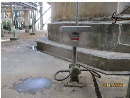
รูปที่ 3.1-1 (รูปที่ 47 Fixed Gas Detector)
