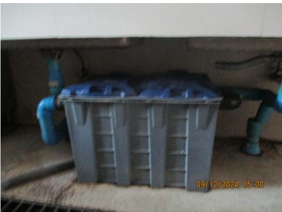
รูปที่ 3.1-1 (รูปที่ 17 ถังคักไขมันที่โรงอาหาร)
