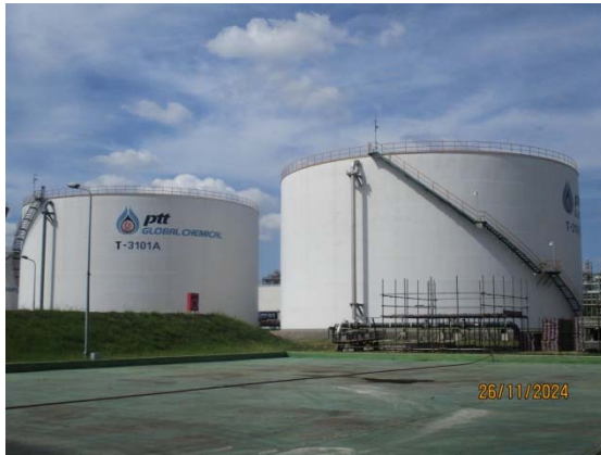
รูปที่ 3.1-1 (รูปที่ 61 Fire Water Tank (15,000 m 3 )
