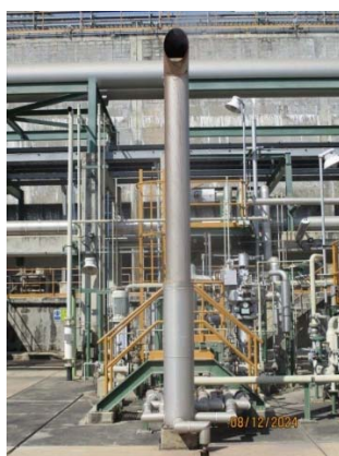
รูปที่ 3.1-1 (รูปที่ 41 การติดตั้ง Silencer บริเวณ Line Steam Vent ของระบบหล่อเย็น)
