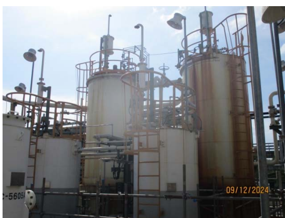
รูปที่ 3.1-1 (รูปที่ 5 ถังปรับสภาพให้เป็นกลาง)
