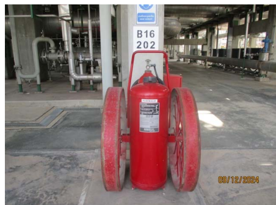
รูปที่ 3.1-1 (รูปที่ 54 Wheeled Fire Extinguisher)
