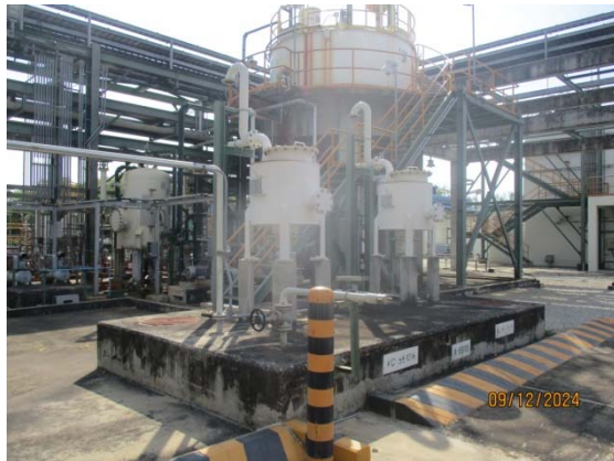
รูปที่ 3.1-1 (รูปที่ 9 ถังแยกน้ำมันแบบ DAF)
