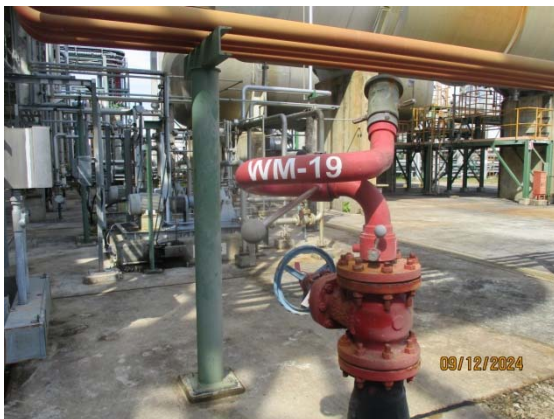
รูปที่ 3.1-1 (รูปที่ 51 Water Hydrants with Monitors)
