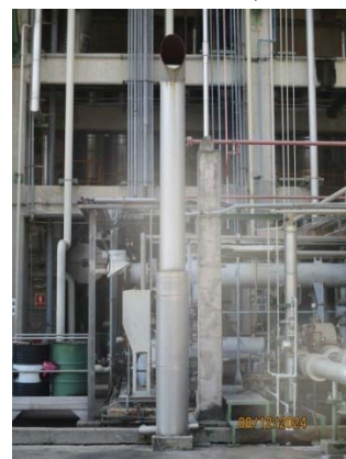
รูปที่ 3.1-1 (รูปที่ 40 การติดตั้ง Silencer บริเวณ Change Gas Compressor)
