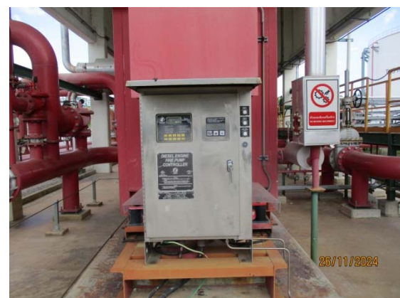
รูปที่ 3.1-1 (รูปที่ 60 Diesel Fire Pump)
