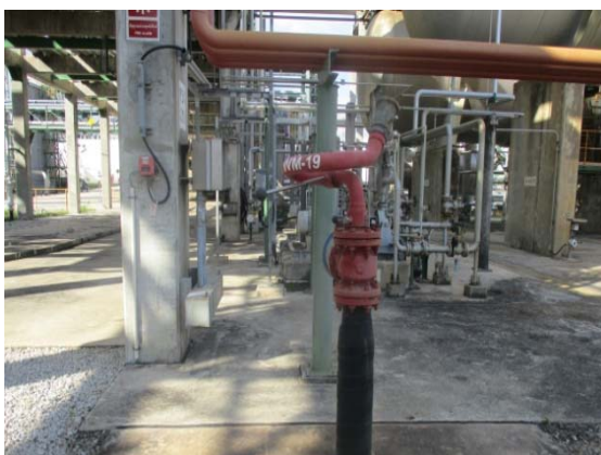
รูปที่ 3.1-1 (รูปที่ 53 Water Fix Monitor)
