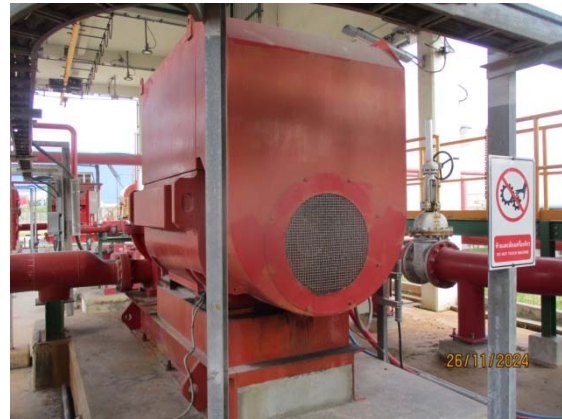
รูปที่ 3.1-1 (รูปที่ 62 Electric Fire Pump)
