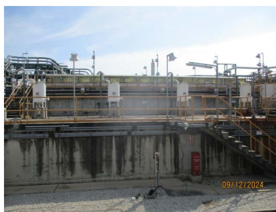
รูปที่ 3.1-1 (รูปที่ 6 ถังปรับเสมอ (Equalization Tank))
