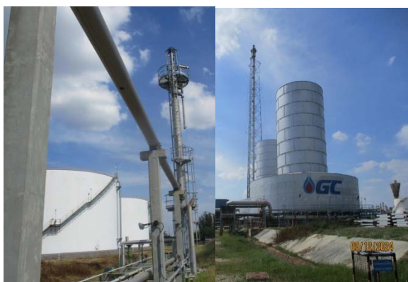
รูปที่ 3.1-1 (รูปที่ 3 หอเผาความดันต่ำ หอเผาความดันสูง และหอแยกชนิด EGF)
