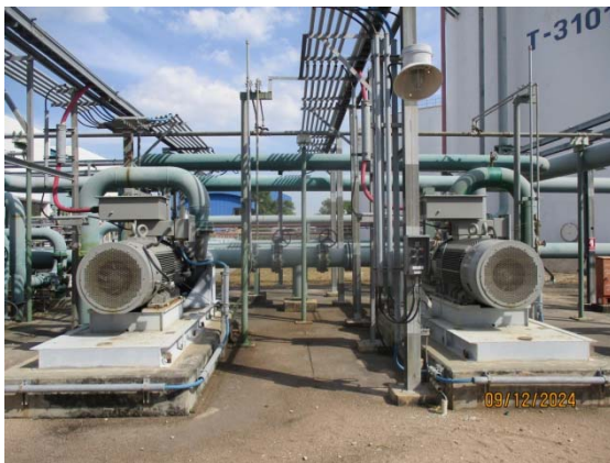
รูปที่ 3.1-1 (รูปที่ 63 Electric Jockey Pump)
