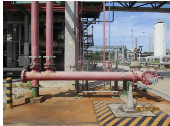
รูปที่ 3.1-1 (รูปที่ 50 Water Spray System)
