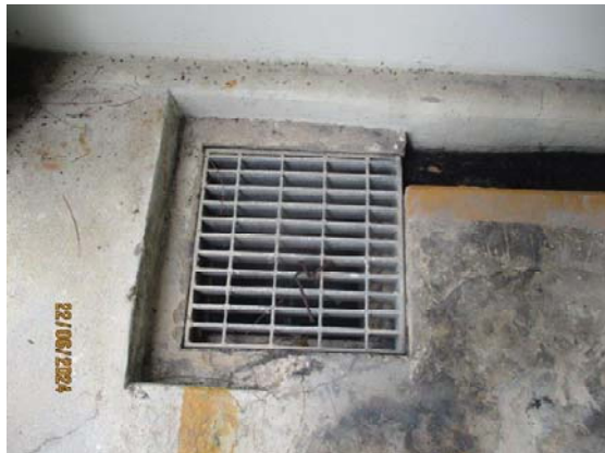
รูปที่ 3.1-1 (รูปที่ 19) บ่อรวบรวมน้ำเสียที่หกรั่วไหล จากอาคารเก็บกากของเสีย)
