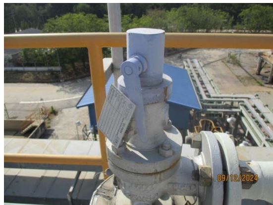
รูปที่ 3.1-1 (รูปที่ 66 Safety Valve (Relief & Vacuum Valve และ Shutoff Valve))
