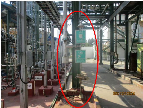
รูปที่ 3.1-1 (รูปที่ 21) Shower & Eyes Washer)
