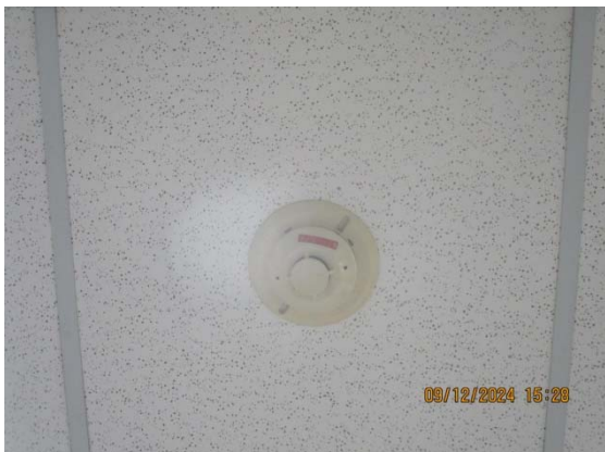
รูปที่ 3.1-1 (รูปที่ 23) Heat Detector)
