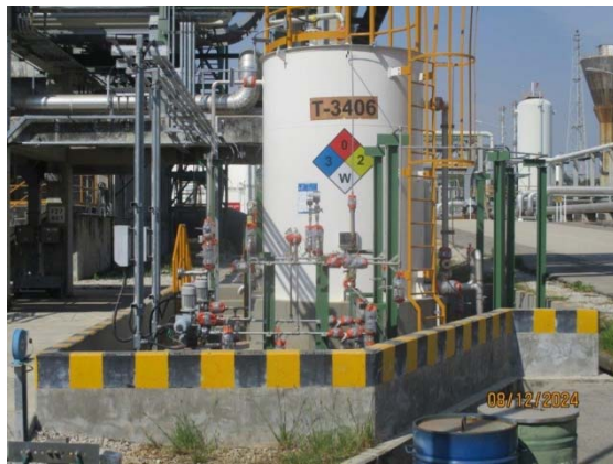
รูปที่ 3.1-1 (รูปที่ 45 คั่นคอนกรีตล้อมรอบ ถังกักเก็บสารเคมี)
