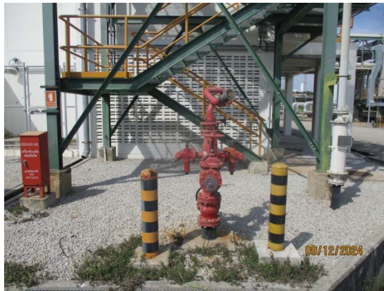
รูปที่ 3.1-1 (รูปที่ 55 Water Hydrants (Indoor & Outdoor))
