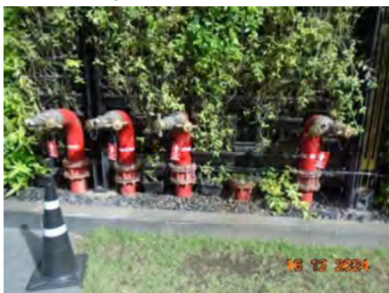
หัวรองรับน้ำดับเพลิงภายนอกอาคาร (Fire Department Connector : FDC)
