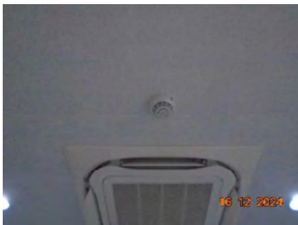
ภาพที่ 2.2-37 เครื่องตรวจจับควัน (Smoke Detector)
