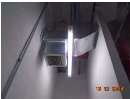
ภาพที่ 2.2-32 เครื่องดูดอากาศ
