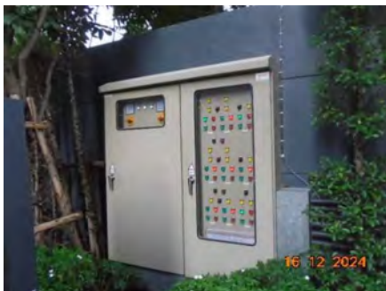
ภาพที่ 2.2-13 ระบบมอเตอร์ไฟฟ้าสำหรับระบบบำบัดน้ำเสีย
