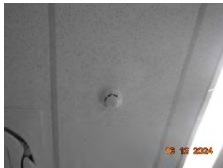
ภาพที่ 2.2-37 เครื่องตรวจจับควัน (Smoke Detector)
