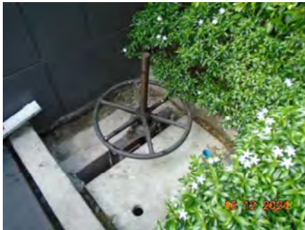
ภาพที่ 2.2-27 ประตุน้ำแบบมือหมุน
