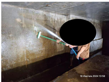
ภาพที่ 2-14 การดูแลรักษาถังเก็บน้ำ และการทำความสะอาด
