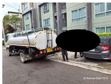
ภาพที่ 2-12 (ต่อ) การสูบกากตะกอน ตักตะกอน ไขมัน
