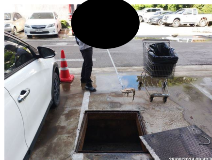
ภาพที่ 2-12 การสูบน้ำตกตะกอน ตักตะกอน ไขมัน
