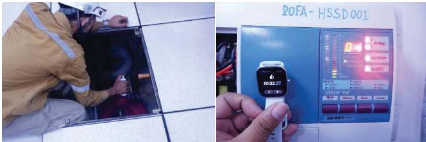
Test Alarm Pipe Line 3 ทดสอบได้เวลา 32.27 วินาที
