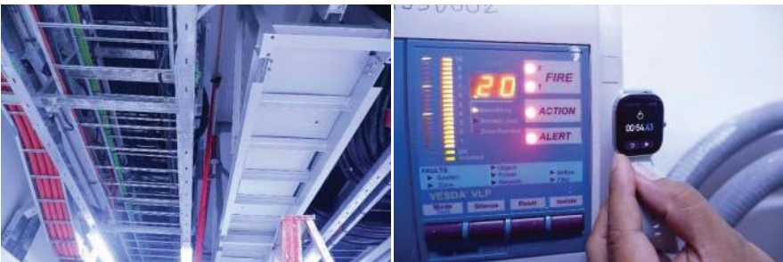
Test Alarm Pipe Line 2 ทดสอบได้เวลา 54.43 วินาที
