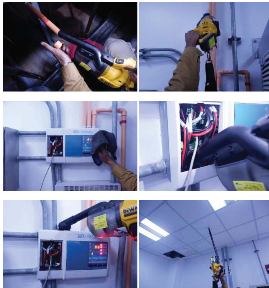
4.5 ทำความสะอาดอุปกรณ์และทำการดูฝุ่นตามรู Detector หลังการทดสอบระบบเสร็จสิ้น
