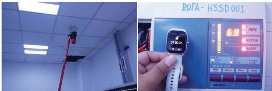
Test Alarm Pipe Line 2 ทดสอบได้เวลา 60.06 วินาที
