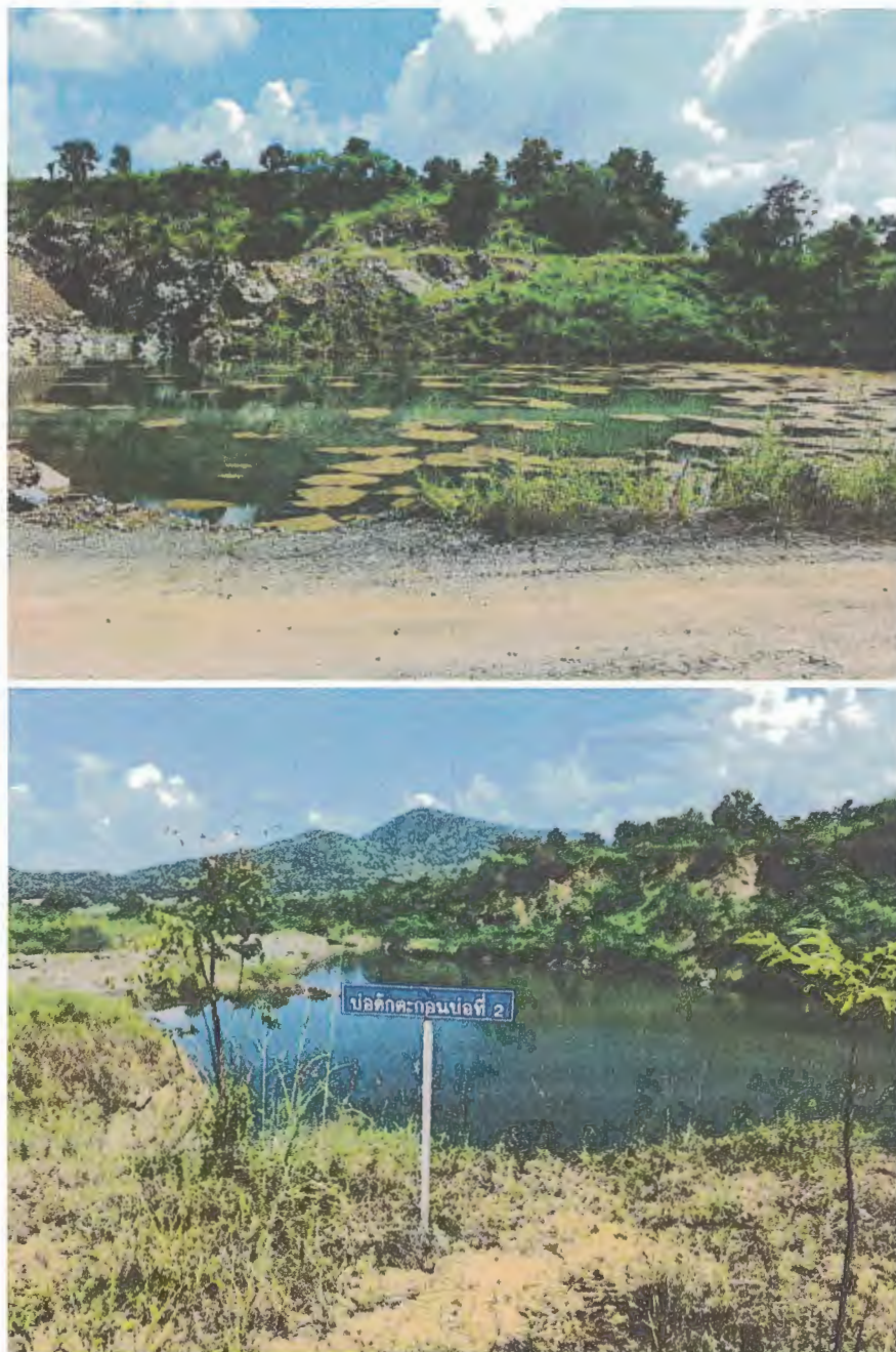
รูปที่ 17 แสดงบ่อดักตะกอน ในบริเวณพื้นที่ทำเหมือง
