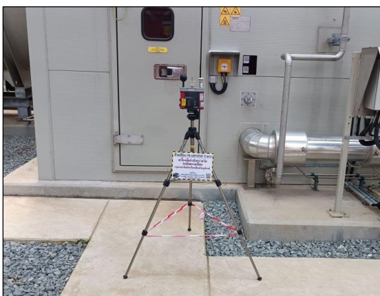
รูปที่ 3.20 การตรวจวัดระดับความร้อนในพื้นที่ทำงาน บริเวณ Gas Turbine Generator
