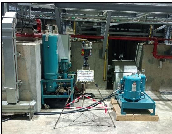
รูปที่ 3.19 การตรวจวัดระดับความร้อนในพื้นที่ทำงาน บริเวณ Steam Turbine Generator
