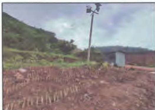
การปลูกหญ้าแฝกช่วงหลักหมุดที่ 8 และ 9
