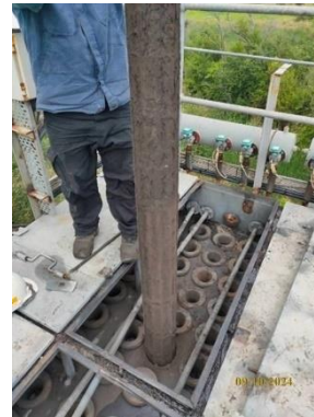
รูปที่ 33 ตะแกรงบริเวณสถานีสูบน้ำ (ตะแกรงอยู่ปลายท่อสูบน้ำ)
