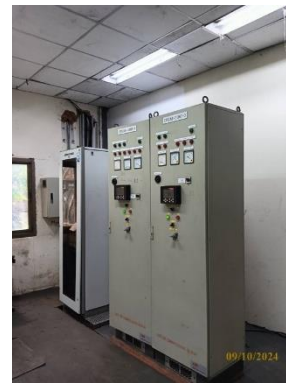
รูปที่ 12 ระบบการแจ้งเตือนกรณี ESP ทำงานขัดข้อง
