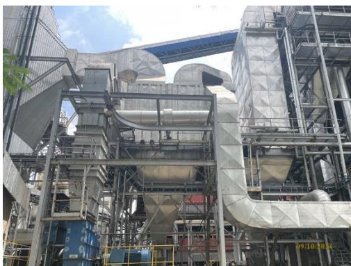
รูปที่ 10 ระบบ Bag Filter
