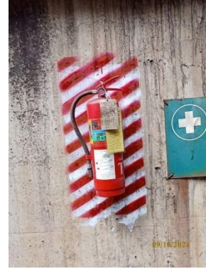
รูปที่ 49 อุปกรณ์ระงับอัคคีภัยบริเวณอาคารเก็บถ่านหิน
