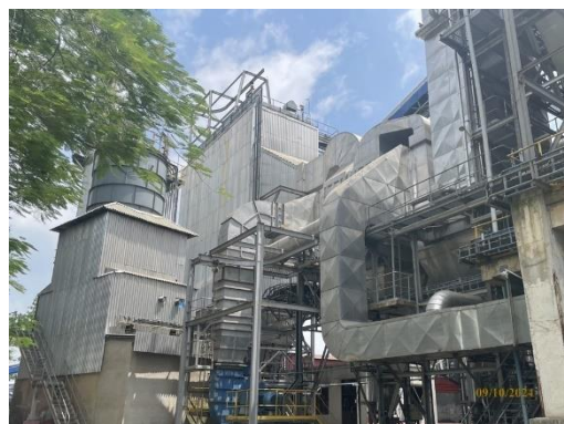
รูปที่ 10 ระบบ Bag Filter
