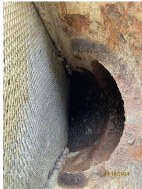
รูปที่ 33 ตะแกรงบริเวณสถานีสูบน้ำ (ตะแกรงอยู่ปลายท่อสูบน้ำ)
