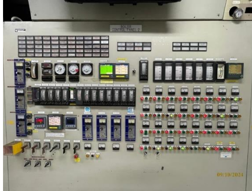
รูปที่ 12 ระบบการแจ้งเตือนกรณี ESP ทำงานขัดข้อง
