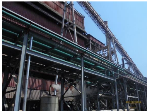
รูปที่ 43 ติดตั้งฉนวนกันความร้อน
