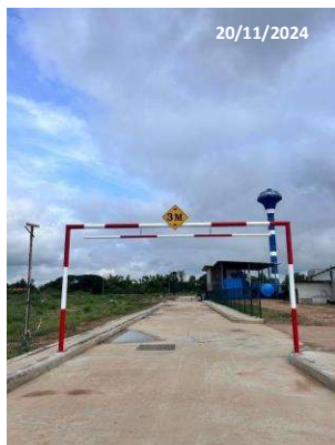
รูปที่ 2-23 การติดตั้งอุปกรณ์ควบคุมความสูง ของรถบรรทุก
