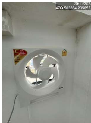
รูปที่ 2-5 ระบบดูดอากาศเฉพาะที่ในบริเวณที่มีการใช้งานสารเคมี
