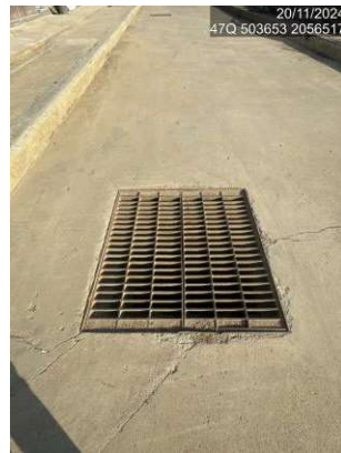
รูปที่ 2-27 ท่อระบายน้ำฝนของโครงการ
