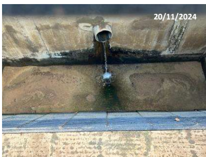
รูปที่ 2-9 บ่อตรวจคุณสมบัติน้ำเสีย (Inspection Manhole)
