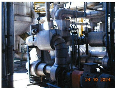
ภาพที่ 2-6 การติดตั้ง Insulation
