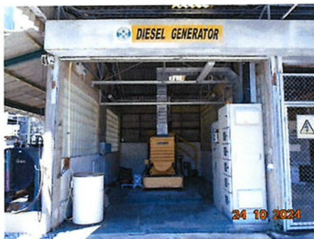
ภาพที่ 2-32 ระบบไฟฟ้าสำรอง (Diesel Generator)
