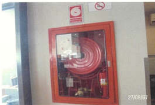
ตู้เก็บสายฉีดน้ำดับเพลิง
