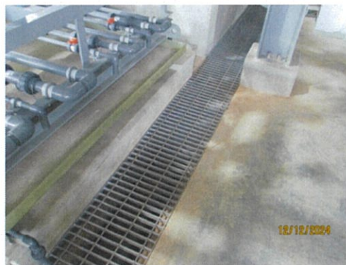
รูปที่ 3-13 รางระบายน้ำเสียของโครงการ
