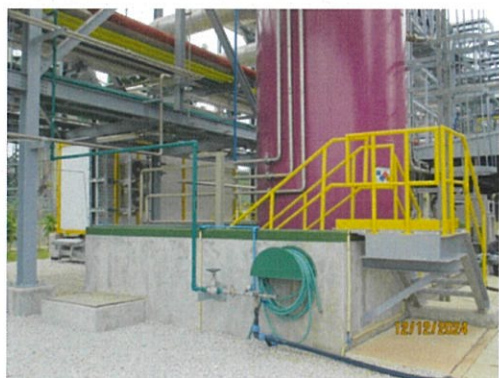
รูปที่ 3-33 เขื่อน (Dike) ล้อมรอบ บริเวณพื้นที่รองรับถังบรรจุงาสารเคมี
