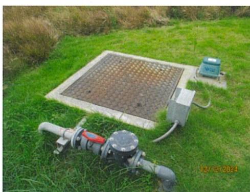
รูปที่ 3-5 ระบบบำบัดน้ำเสียสำเร็จรูป บริเวณอาคารสำนักงาน
