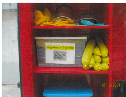
รูปที่ 3-36 อุปกรณ์ดูดซับสารเคมี
