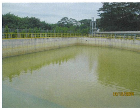
รูปที่ 3-15 บ่อหน่วงน้ำฝนของโครงการ
