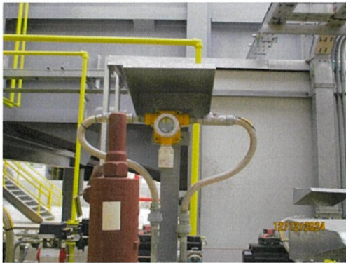
รูปที่ 3-39 Gas Detector
