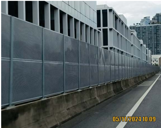
รูปที่ 3.2-5 กำแพงกันเสียง บริเวณ กม. 2+100B ถึง 2+400B (SIRI CAMPUS)
