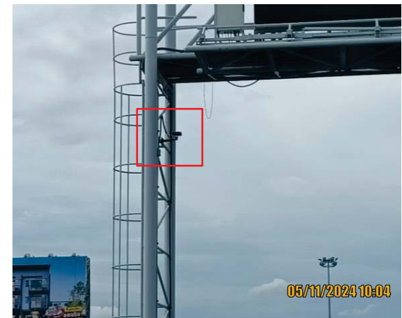
รูปที่ 3.2-13 กล้องโทรทัศน์วงจรปิด ตรวจจับรถวิ่งไหล่ทางพิเศษฉลองรัช
