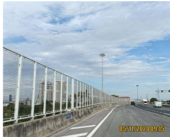
รูปที่ 3.1-13 กำแพงตาข่ายป้องกันวัสดุตกหล่น
