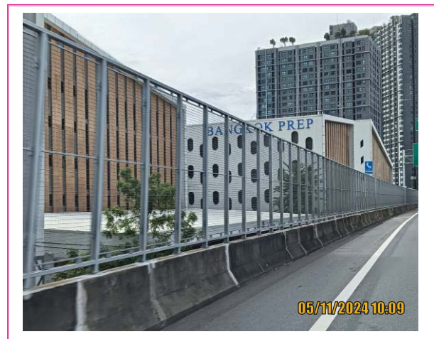
รูปที่ 3.2-4 กำแพงตาข่ายป้องกันวัสดุตกหล่น บริเวณ 1+800B ถึง 2+100B (โรงเรียนนานาชาติ บางกอกพรีแพรเออรี แอนด์ เซ็กเคินเดอร์รี่ (Bangkok Prep))
