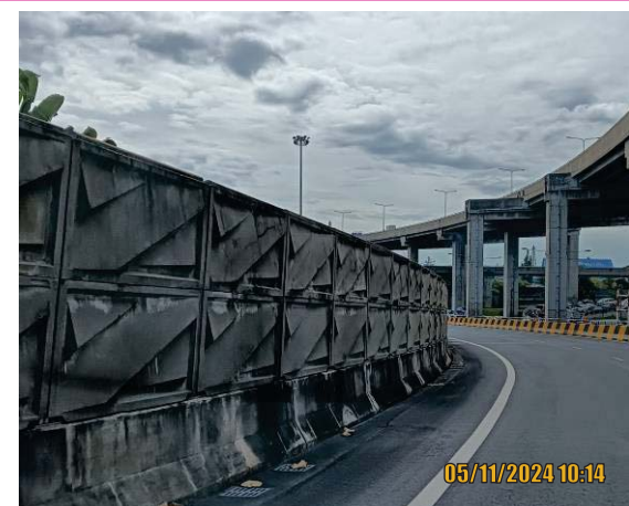
รูปที่ 3.1-7 กำแพงกันเสียงบริเวณหมู่บ้านพรประดิษฐ์วิลล่า (ทางลดด่านเก็บค่าผ่านทางพิเศษอาจณรงค์ 1)
