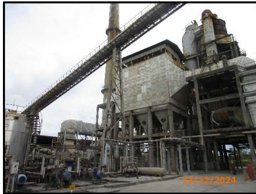
ภาพที่ 11 Electrostatic Precipitator ซึ่งมีประสิทธิภาพการทำงานมากกว่า 99 %
