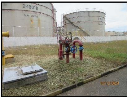
ภาพที่ 28 ติดตั้งระบบฉีดน้ำ และระบบโพนภายในถังและ Hydrant สำหรับสารเคมี เพื่อใช้ในการดับเพลิง
