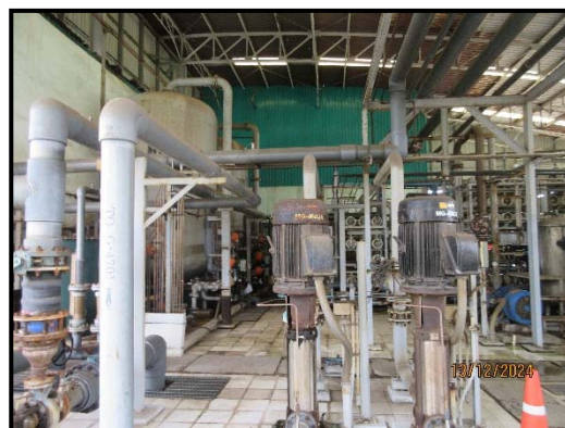
ภาพที่ 13 หน่วยนำน้ำเสียกลับคืน (Wastewater Recovery Unit) เพื่อนำน้ำเสียจากกระบวนการทำบริสุทธิ์ มาผลิตเป็นน้ำ RO
