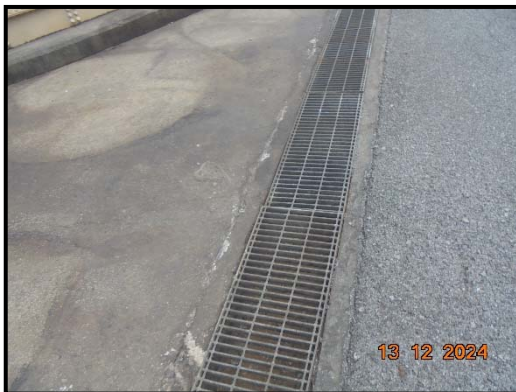
ภาพที่ 15 รางระบายน้ำภายในโครงการ
