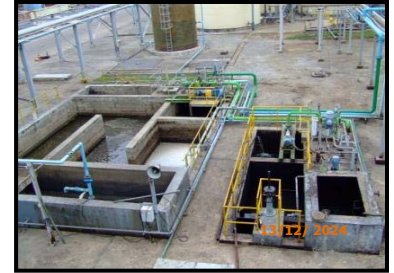
ภาพที่ 14 ระบบบำบัดน้ำเสีย ที่รองรับน้ำเสียจากหน่วยนำน้ำเสียกลับคืน โดยระบบบำบัดน้ำเสียแบบ Anaerobic System ชนิด UASB และ Aerobic System ชนิด Activated Sludge
