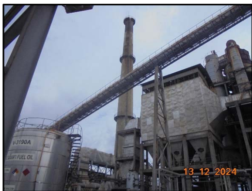
ภาพที่ 1 ปล่องสูง 80 เมตร และติดตั้งระบบตรวจมลพิษแบบอัตโนมัติ เพื่อส่งข้อมูลให้ทางกรมฯ
