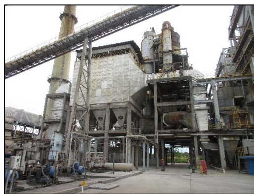
ภาพที่ 1 ปล่องสูง 80 เมตร และติดตั้งระบบตรวจมลพิษแบบอัตโนมัติ เพื่อส่งข้อมูลให้ทางกรมฯ
