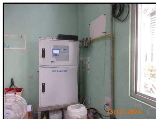
ภาพที่ 18 เครื่องมือตรวจวัดคุณภาพน้ำอัตโนมัติ
