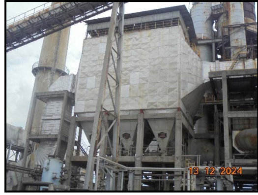
ภาพที่ 10 ติดตั้งระบบกำจัดซัลเฟอร์ไดออกไซด์ ( \text{DeSO}_x ) เพื่อควบคุม \text{SO}_2 ให้ได้ตามมาตรฐาน และเกณฑ์ที่ EIA (52 ppm) กำหนด
