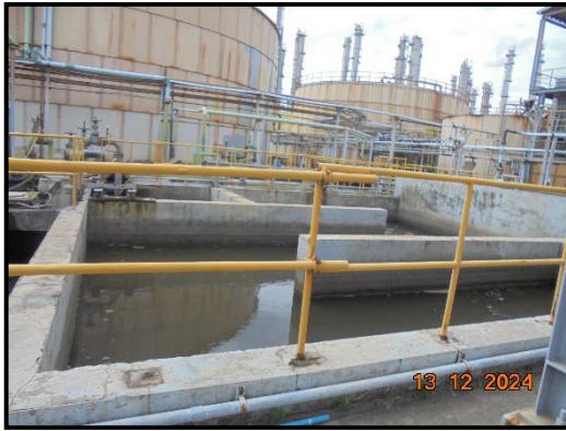
ภาพที่ 16 บ่อ API เพื่อรวบรวมน้ำระบายทิ้งจากระบบหล่อเย็น
