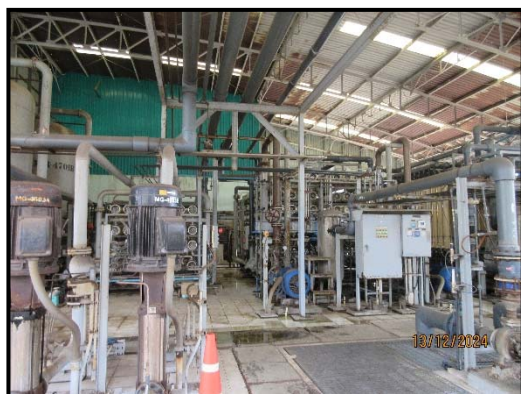
ภาพที่ 13 หน่วยนำน้ำเสียกลับคืน (Wastewater Recovery Unit) เพื่อนำน้ำเสียจากกระบวนการทำบริสุทธิ์ มาผลิตเป็นน้ำ RO
