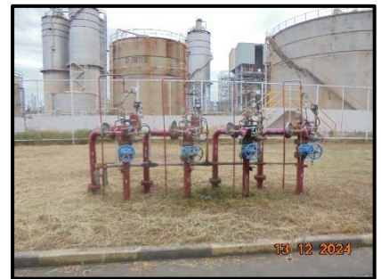
ภาพที่ 28 ติดตั้งระบบฉีดน้ำ และระบบโพนภายในถังและ Hydrant สำหรับสารเคมี เพื่อใช้ในการดับเพลิง
