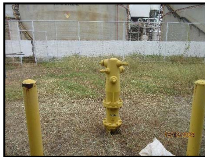
ภาพที่ 28 ติดตั้งระบบฉีดน้ำ และระบบโพนภายในถังและ Hydrant สำหรับสารเคมี เพื่อใช้ในการดับเพลิง
