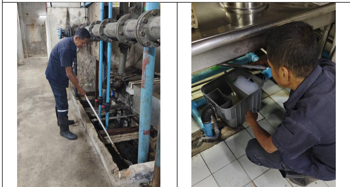
รูปที่ 2 การทำความสะอาดบ่อกักน้ำทิ้งและถังดักไขมัน
