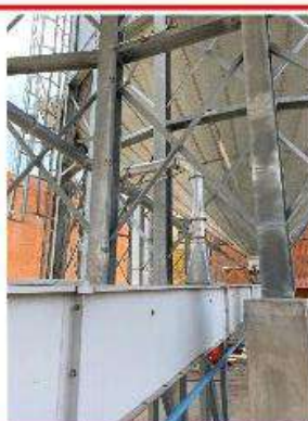
ฝุ่นถูกดูดไล่เลียงผ่านท่อเพื่อเข้าสู่ Dust Collector
