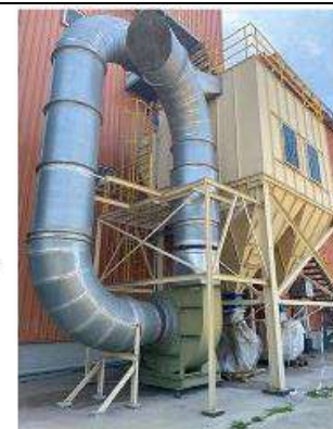
ฝุ่นถูกดูดเพื่อไปเก็บที่ Dust collector
