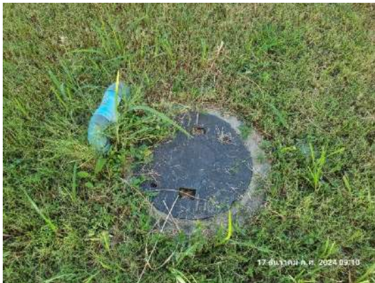
รูปที่ 2-10 ถังบำบัดน้ำเสียสำเร็จรูป
