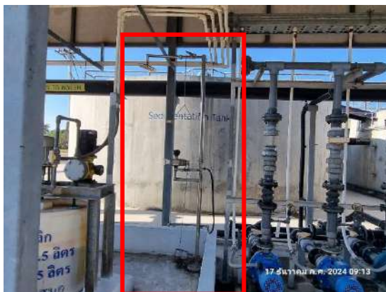
รูปที่ 2-26 ฝักบัวฉุกเฉินและอ่างล้างตา
