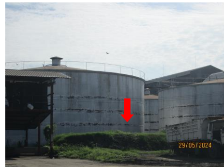
รูป 2-55 : เขื่อนคันดินรอบถังโมลาส (ถังเก็บกากน้ำตาล)
