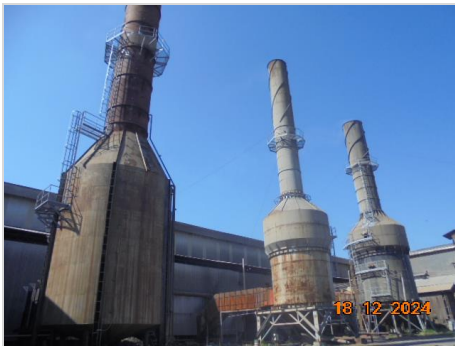
รูป 2-2 : ป้อนน้ำของสำหรับระบบควบคุมมลพิษอากาศ (Wet Scrubber)
