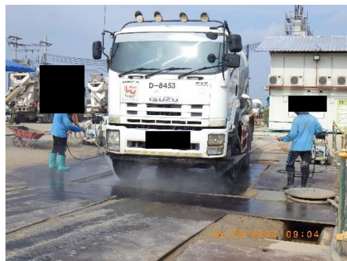
รูปที่ 2-8 การทำความสะอาดล้อรถบรรทุกก่อน ออกจากเขตก่อสร้าง
