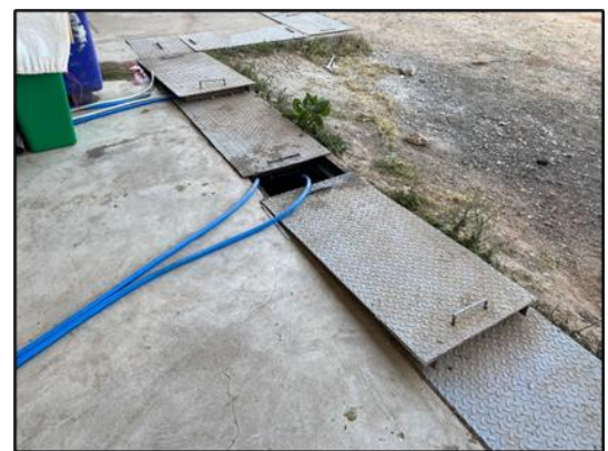
รูปที่ 2.2-23 บ่อดักไขมันหลังอาคารโรงอาหารและการทำความสะอาดบ่อดักไขมัน
