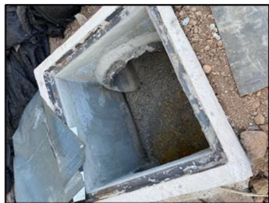
รูปที่ 2.2-23 บ่อดักไขมันหลังอาคารโรงอาหารและการทำความสะอาดบ่อดักไขมัน
