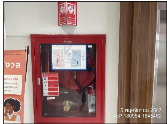
รูปที่ 2.2-35 อุปกรณ์ดับเพลิง สายส่งน้ำ (Fire Hose) ยาว 30 เมตร ภายในโครงการ
