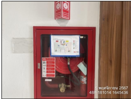
รูปที่ 2.2-35 อุปกรณ์ดับเพลิง สายส่งน้ำ (Fire Hose) ยาว 30 เมตร ภายในโครงการ
