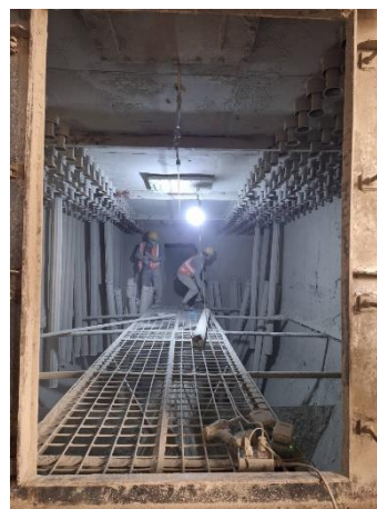
รูปที่ 9 การเปลี่ยนและตรวจสอบถุงกรอง
