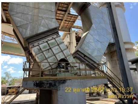
รูปที่ 15 การติดตั้ง Damper ที่ท่อลมของ EP
