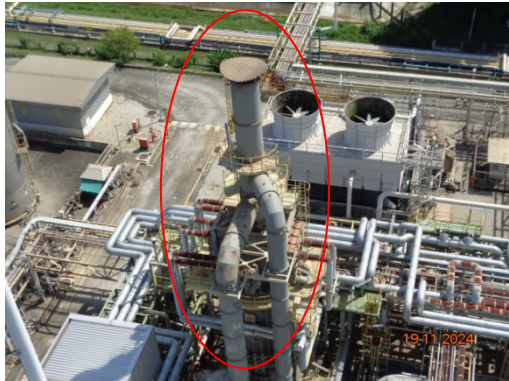
รูปที่ 3.1-1 ปล่องระบายอากาศ HTM Heater ชุดที่ 1 (F-1901)
