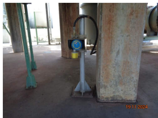
รูปที่ 3.1-31 Gas Detector
