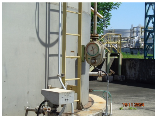
รูปที่ 3.1-43 อุปกรณ์วัดระดับสารเคมี (Level Indicator, Level Gauge)
