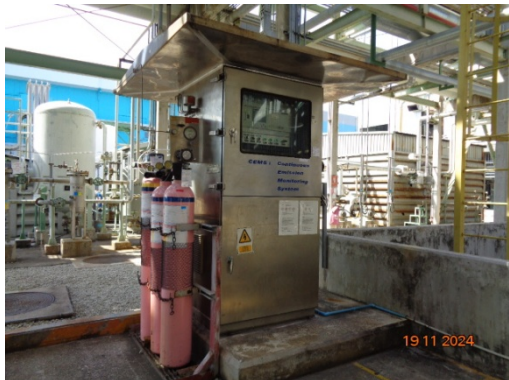
รูปที่ 3.1-3 Continuous Emission Monitoring System, CEMS
