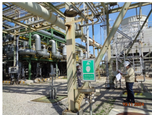
รูปที่ 3.1-30 ฝักบัวและอ่างล้างตาฉุกเฉิน
