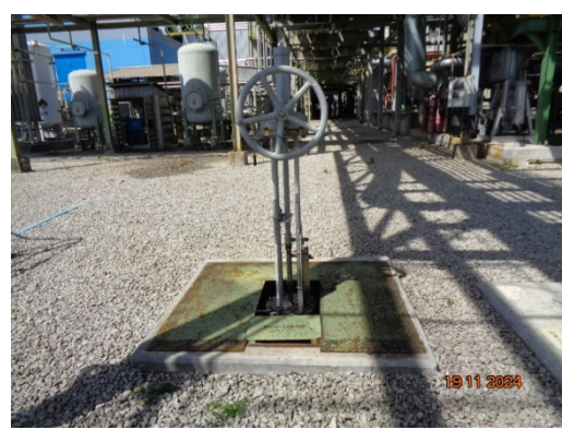
รูปที่ 3.1-16 วาล์วตัดแยกระบบบำบัดน้ำเสีย
