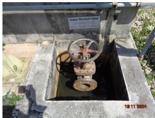
รูปที่ 3.1-42 Block Valve
