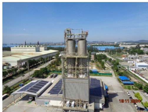
รูปที่ 3.1-6 Cyclone ชุดที่ 3 และ 4 (MC-1614 และ MC-1624)
