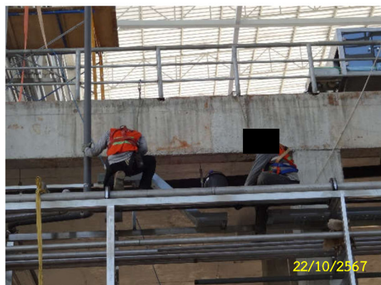
ภาพที่ 22 คนงานที่ทำงานบนที่สูงสวมใส่อุปกรณ์ป้องกันอันตรายส่วนบุคคล (PPE)
