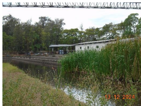
ภาพที่ 2-6 บ่อดักตะกอน (Run off pond) สำหรับบำบัด น้ำเสียจากกิจกรรมการขนถ่ายถ่านหิน
