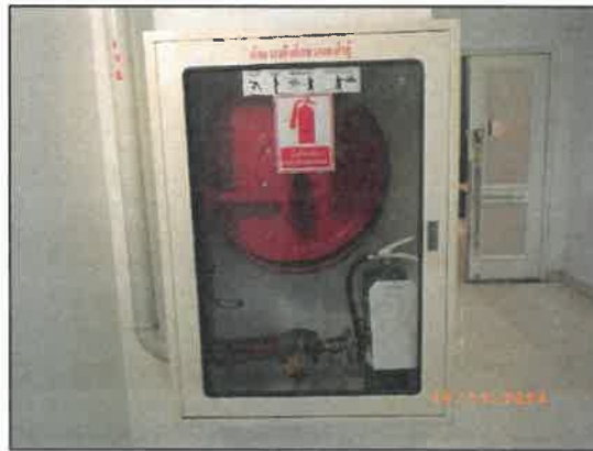
รูปที่ 2-22 (ต่อ) ตู้เก็บสายฉีดน้ำดับเพลิงพร้อมอุปกรณ์
