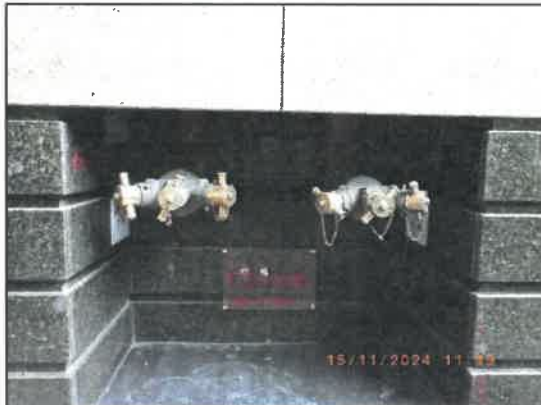
รูปที่ 2-23 หัวรับน้ำดับเพลิงภายนอกอาคาร
