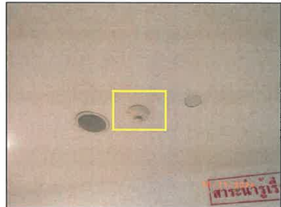
รูปที่ 2-24 ระบบดับเพลิงอัตโนมัติ
