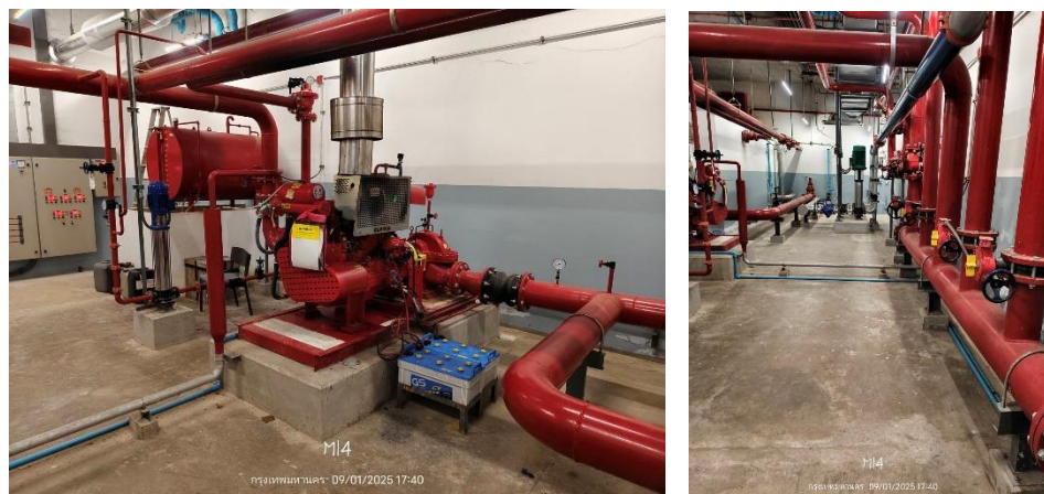
ภาพที่ 2.38 Fire Water Pump
