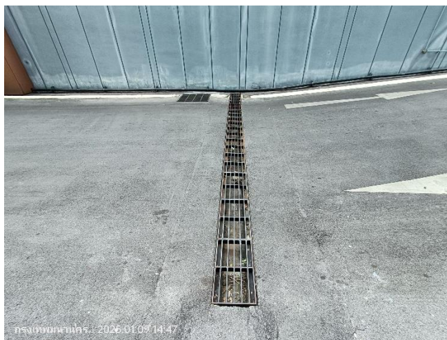
ภาพที่ 2.13 ตะแกรงดักขยะ
