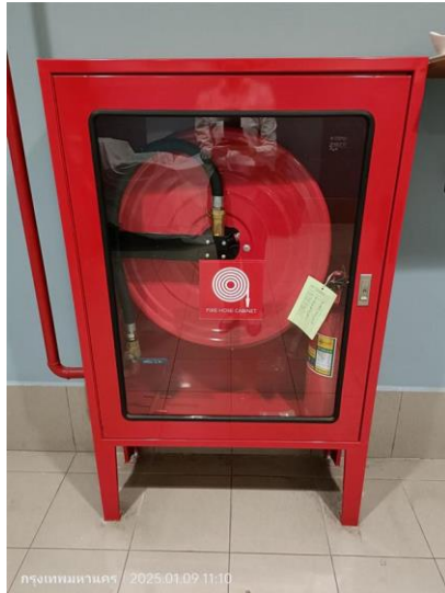
ภาพที่ 2.21 ตู้เก็บสายฉีดน้ำดับเพลิง พร้อมอุปกรณ์
