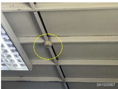
ภาพที่ 2.2-37 ระบบตรวจจับความร้อน (Heat Detector) บริเวณพื้นที่ Store
