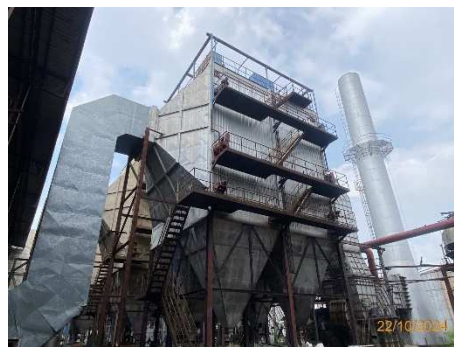
ภาพที่ 2.2-6 อุปกรณ์ดักฝุ่น แบบ Electrostatic Precipitator
