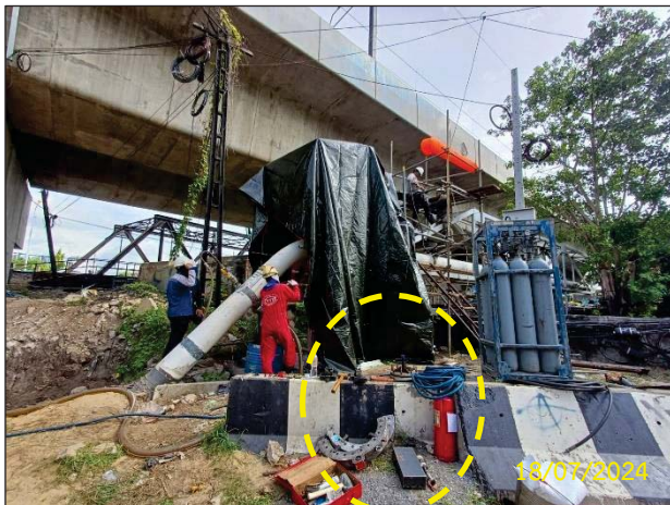
ข) จัดเตรียมอุปกรณ์ดับเพลิงในบริเวณที่อาจก่อให้เกิดประกายไฟในพื้นที่ก่อสร้าง ในช่วงงานทดสอบท่อ
