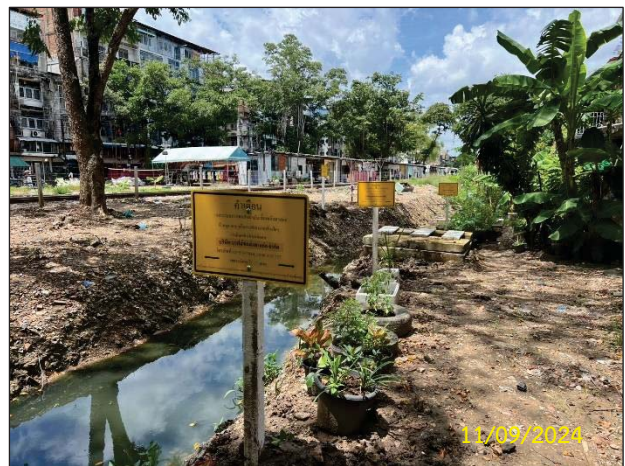
รูปที่ 2-15 ตัวอย่างการติดตั้งป้ายเตือนแสดงตำแหน่งแนววางท่อ และหมายเลขโทรศัพท์ในการแจ้งเหตุฉุกเฉินตลอดแนวท่อ
