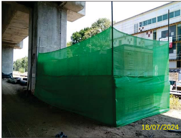
จ) การกั้นแบ่งเขตพื้นที่จัดวาง เครื่องจักร อุปกรณ์เครื่องมืออย่างชัดเจน
