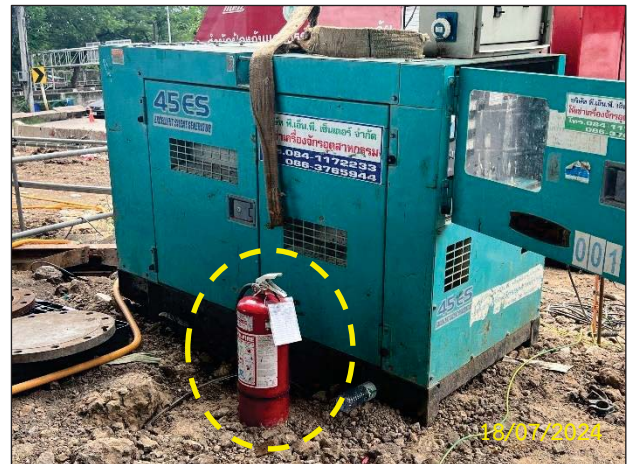
ข) จัดเตรียมอุปกรณ์ดับเพลิงในบริเวณที่อาจก่อให้เกิดประกายไฟในพื้นที่ก่อสร้าง ในช่วงงานทดสอบท่อ
