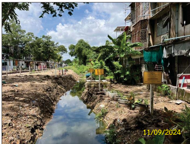
รูปที่ 2-15 ตัวอย่างการติดตั้งป้ายเตือนแสดงตำแหน่งแนววางท่อ และหมายเลขโทรศัพท์ในการแจ้งเหตุฉุกเฉินตลอดแนวท่อ
