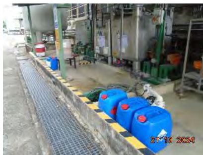
ภาพที่ 2-57 Bund Wall บริเวณที่เก็บสารเคมี
