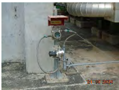
ภาพที่ 2-5 Gas Detector
