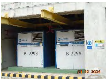
ภาพที่ 2-27 Acoustic Enclosure บริเวณ B-229 A/B
