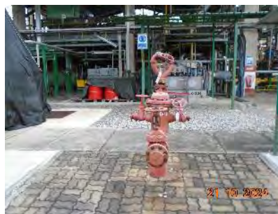
ภาพที่ 2-34 Three-Way Valve (Fixed Monitor)
