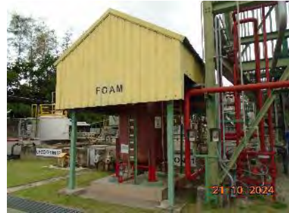
ภาพที่ 2-48 Foam Bladder Tank
