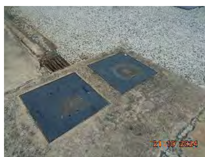
ภาพที่ 2-22 บ่อพักน้ำ (Sump)
