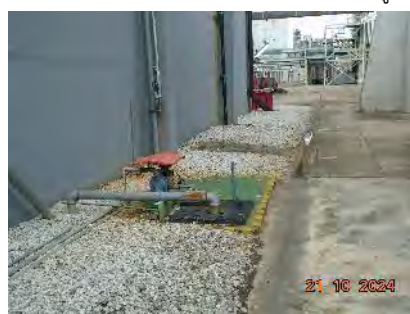
ภาพที่ 2-20 บ่อพักน้ำเสียจากหน่วย Initiator และ Catalyst
