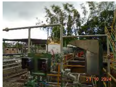
ภาพที่ 2-24 ท่อส่งน้ำจาก API Separator ไป Check Pond
