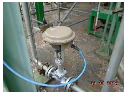
ภาพที่ 2-4 Control Valves
