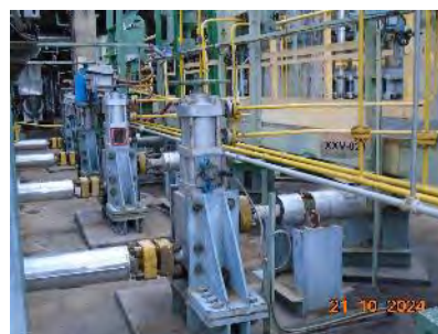
ภาพที่ 2-32 Interlock Valve บริเวณถังปฏิกรณ์
