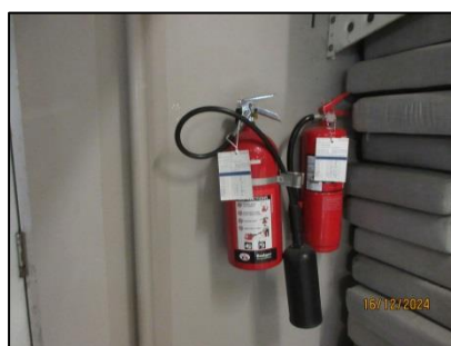
รูปที่ 25 อุปกรณ์ป้องกันอัคคีภัยและป้ายแนะนำการใช้งาน
