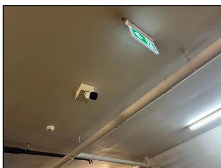
รูปที่ 37 ระบบกล้องวงจรปิด (CCTV)
