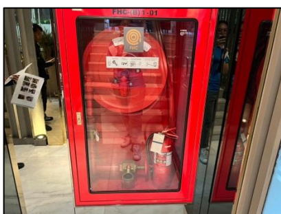
รูปที่ 25 อุปกรณ์ป้องกันอัคคีภัยและป้ายแนะนำการใช้งาน
