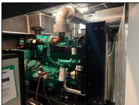
รูปที่ 51 เครื่องกำเนิดไฟฟ้าสำรอง
