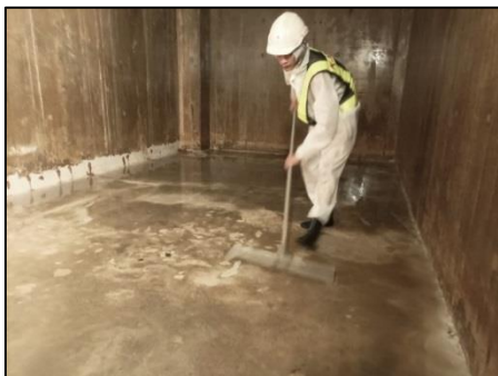
รูปที่ 54 เจ้าหน้าที่ล้างถังสำรองน้ำ
