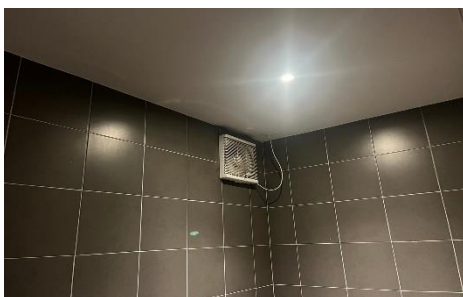
ระบบระบายอากาศภายในห้องพักรมูลฝอย
