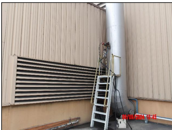
รูปที่ 3.9 การเก็บตัวอย่างคุณภาพอากาศเพื่อตรวจสอบประสิทธิภาพของระบบดักกรองฝุ่น
