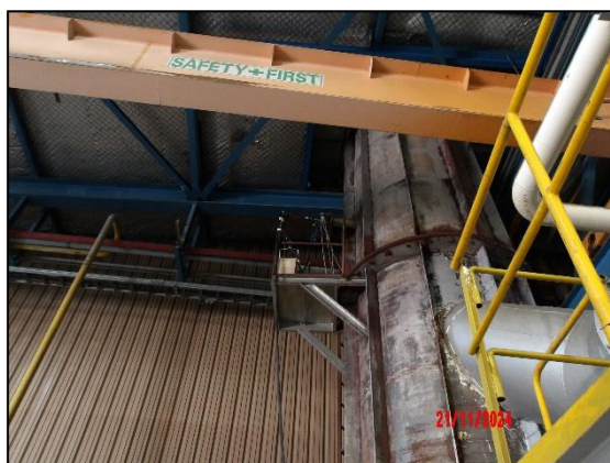
รูปที่ 3.2 การเก็บตัวอย่างคุณภาพอากาศจากแหล่งกำเนิดปล่องระบาย บริเวณ Hot Mill Stack
