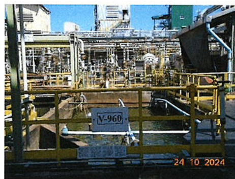
ภาพที่ 2-4 API Separator
