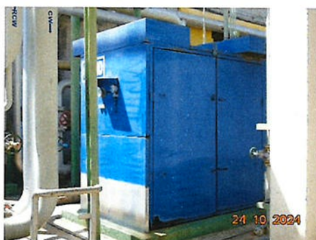
ภาพที่ 2-8 ผนังกันเสียงบริเวณเครื่องจักรที่เป็นแหล่งกำเนิดเสียงดังมากกว่า 85 เดซิเบล(เอ)
