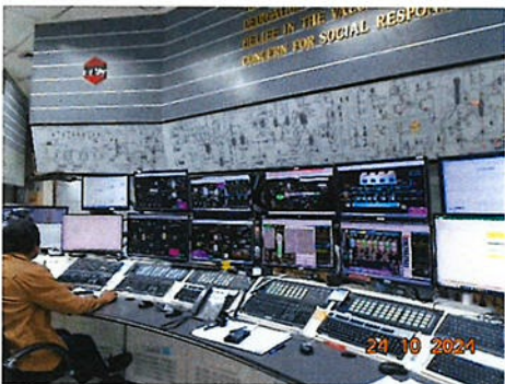
ภาพที่ 2-20 ลักษณะแผงควบคุมการทำงานของเครื่องจักร และระบบควบคุมการผลิต
