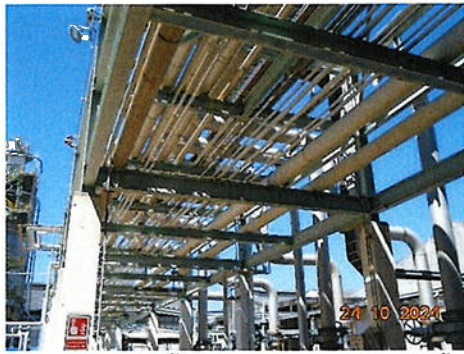
ภาพที่ 2-23 การติดตั้งท่อนส่งบนฐานรองรับเหนือพื้น
