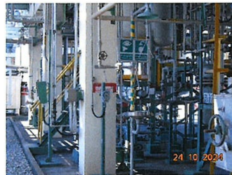
ภาพที่ 2-28 ฝักบัวฉุกเฉินและที่ลั้งตาฉุกเฉิน
