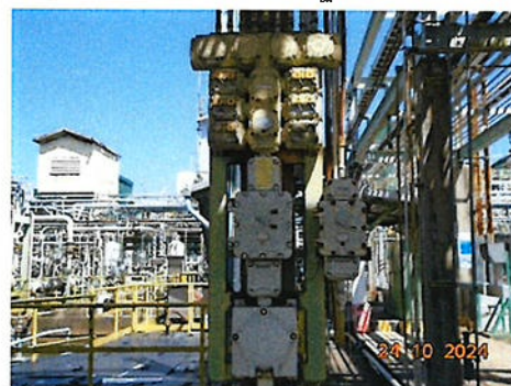
ภาพที่ 2-21 ระบบไฟฟ้าแบบ Explosion Proof
