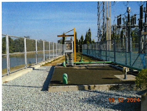
ภาพที่ 2.2-15 ถังแยกน้ำและน้ำมัน
