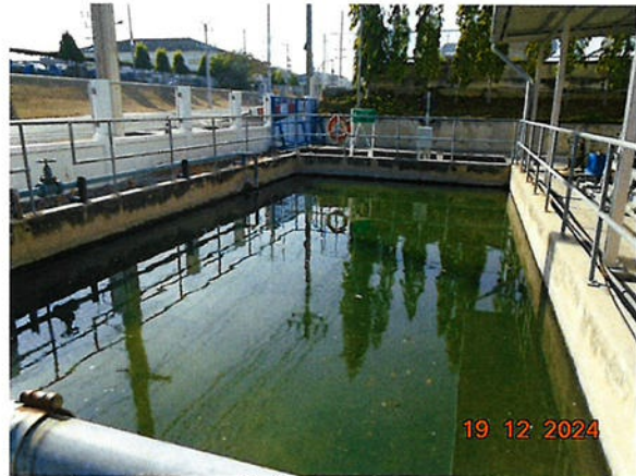
ภาพที่ 2.2-17 บ่อพักน้ำทิ้ง (Wastewater Holding Pond)
