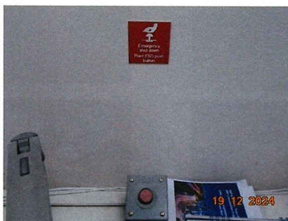
ภาพที่ 2.2-56 ปุ่ม Emergency shutdown
