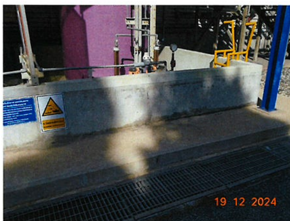
ภาพที่ 2.2-52 คันคอนกรีตล้อมรอบที่เก็บสารเคมี
