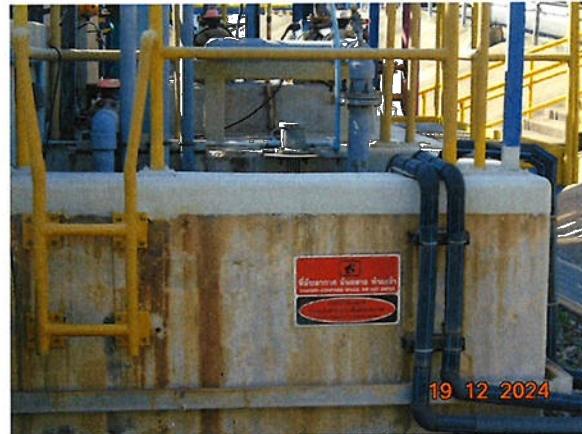
ภาพที่ 2.2-17 ถังปรับสภาพน้ำให้เป็นกลาง (Neutralization pit)
