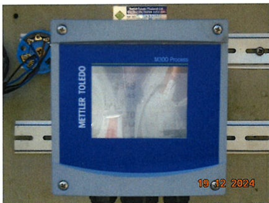
ภาพที่ 2.2-20 เครื่องแสดงผลการตรวจวัดค่าความเป็นกรด-ด่าง อุณหภูมิ และค่าความนำไฟฟ้าแบบอัตโนมัติ
