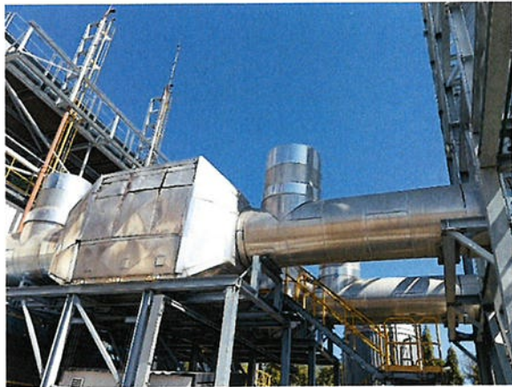
ภาพที่ 2.2-7 selective catalytic reduction; SCR
