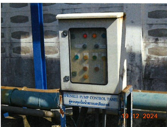
ภาพที่ 2.2-26 ตู้ควบคุมปั๊มน้ำทิ้งกลับมาใช้น้ำดื่ม
