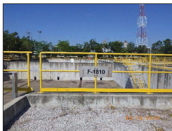
รูปที่ 3.60 บ่อ F-1810 รองรับน้ำไหลของสารเคมี
