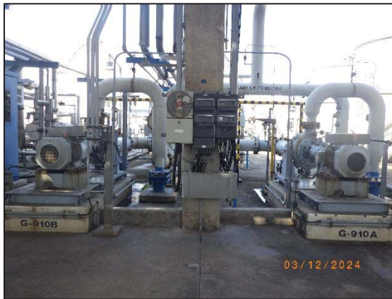
รูปที่ 3.50 Pump ชนิด Double Mechanical Seal
