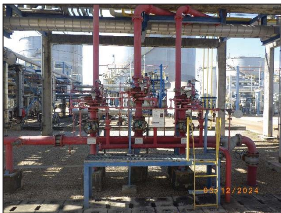
รูปที่ 3.42 Deluge System บริเวณถังเอทิลีนออกไซด์
