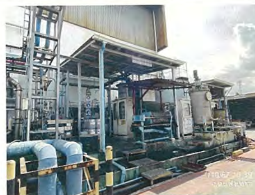
รูปที่ 26 ระบบบำบัดน้ำเสียแบบเคมี
