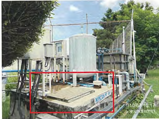
รูปที่ 22 บ่อตรวจสอบคุณภาพน้ำทั้ง (Inspection Pit) ของระบบบำบัดน้ำเสียแบบชีวภาพ
