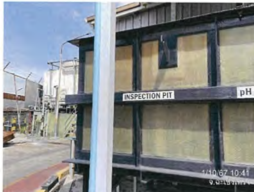
รูปที่ 28 บ่อตรวจสอบคุณภาพน้ำทิ้ง (Inspection Pit) ของระบบบำบัดน้ำเสียแบบเคมี
