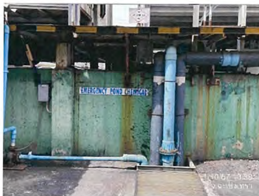
รูปที่ 29 บ่อพักน้ำทิ้งฉุกเฉิน (Emergency Pond) ของระบบบำบัดน้ำเสียแบบเคมี
