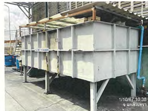
รูปที่ 27 ถังพักน้ำเสียจากระบบดักจับฝุ่นแบบเปียก (Wet Scrubber)
