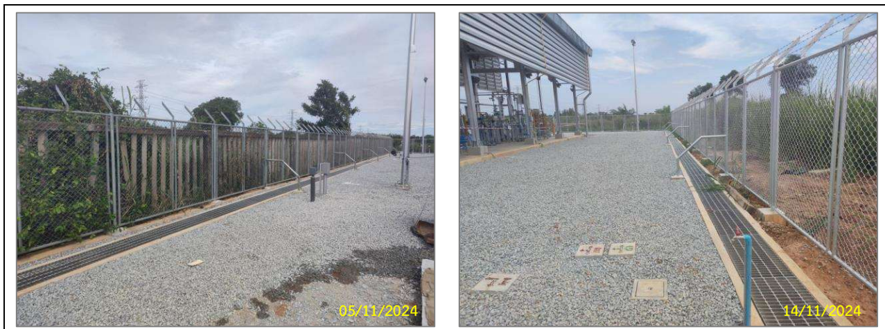
รูปที่ 2-35 รางระบายน้ำโดยรอบพื้นที่สถานีควบคุมและปรับลดความดันก๊าซธรรมชาติ (Gate Station)
