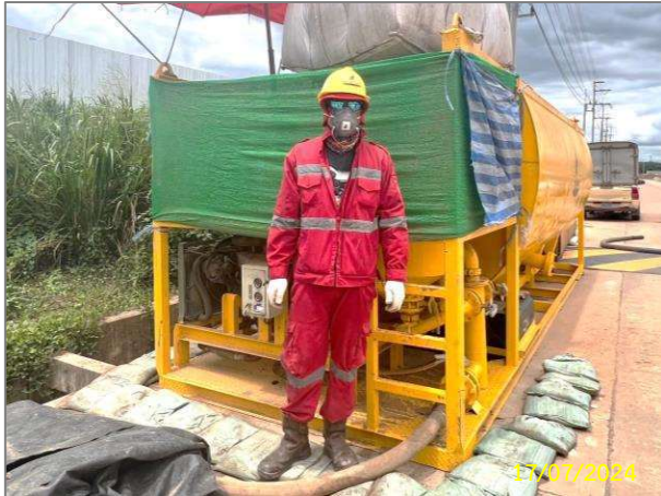
เจ้าหน้าที่ผสมโซเดียมเบนทอไนต์เพื่อใช้ในการเจาะลุดให้พอดีกับปริมาณงาน
