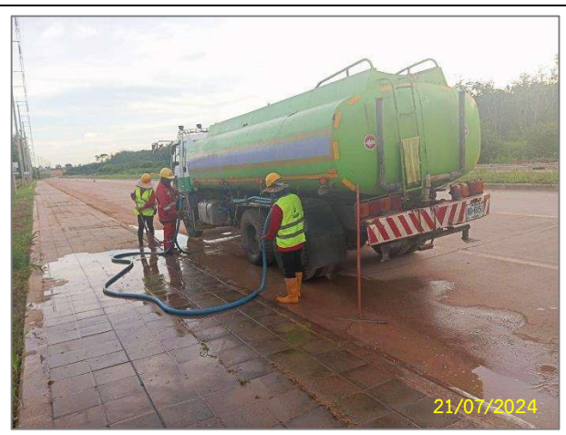
รูปที่ 2-4 การฉีดพรมน้ำบริเวณพื้นที่ก่อสร้างและเส้นทางคมนาคมในบริเวณใกล้เคียงพื้นที่ก่อสร้าง
