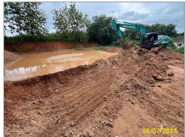
การจัดเตรียมพื้นที่ทั้งโคลนโซเดียมเบนทอนต์ (ระดับพื้นบ่ออยู่สูงกว่าระดับน้ำใต้ดินไม่น้อยกว่า 1 เมตร)
