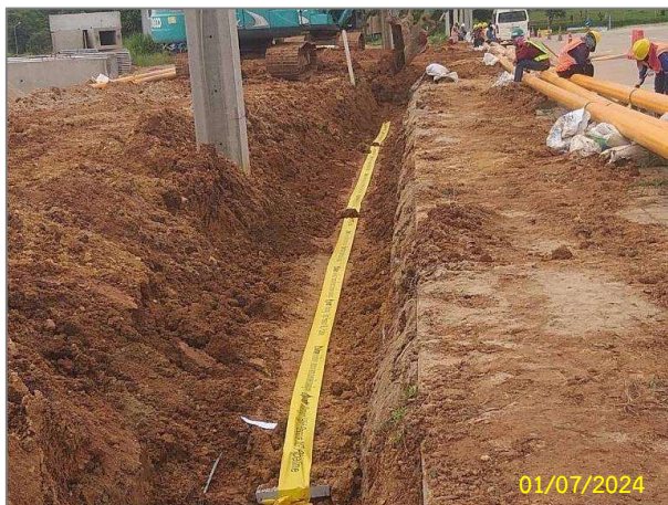
การวางแถบสีเหลือง (Warning Tape)
