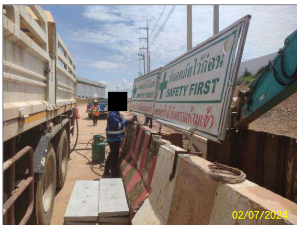
การกั้นเขตพื้นที่ก่อสร้าง พร้อมติดตั้งป้ายสัญญาณแสดงบริเวณที่ทำการชุด และเครื่องหมายเตือนแสดงเขตหวงห้ามที่อาจเกิดอันตราย ขณะรถแบ็คโฮกำลังปฏิบัติงาน
