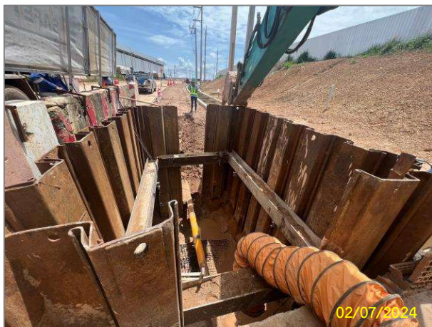
การติดตั้ง Sheet Pile
