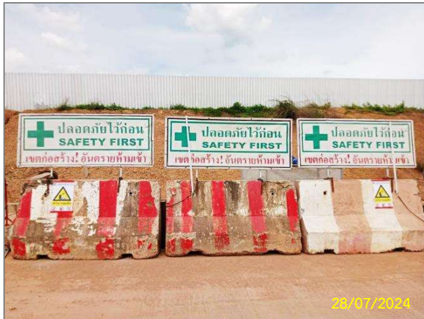
ติดตั้งกำแพงคอนกรีตกันโดยรอบเขตพื้นที่ก่อสร้าง
