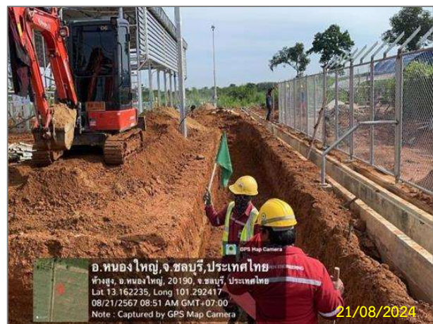
เจ้าหน้าที่ความปลอดภัยในการทำงานตรวจสอบ ไม่ให้มีสิ่งกีดขวาง และผู้ปฏิบัติงานอยู่ในระยะ ที่อาจเกิดอันตรายจากกิจกรรมการยกท่อลงร่องขุด
