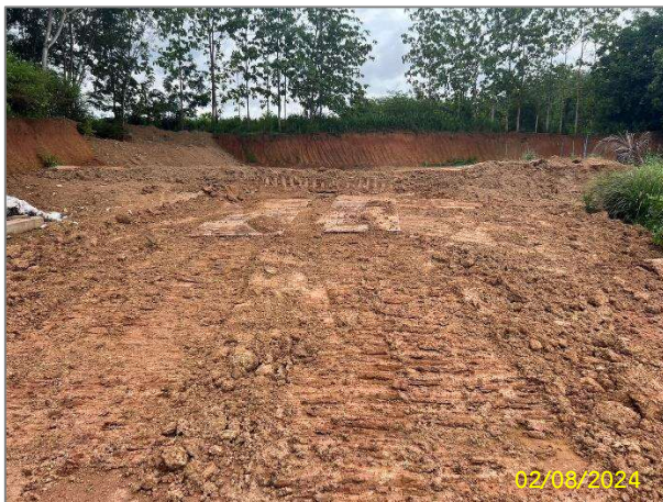
การจัดเตรียมพื้นที่ทั้งโคลนโซเดียมเบนทอนต์ (ระดับพื้นบ่ออยู่สูงกว่าระดับน้ำใต้ดินไม่น้อยกว่า 1 เมตร)
