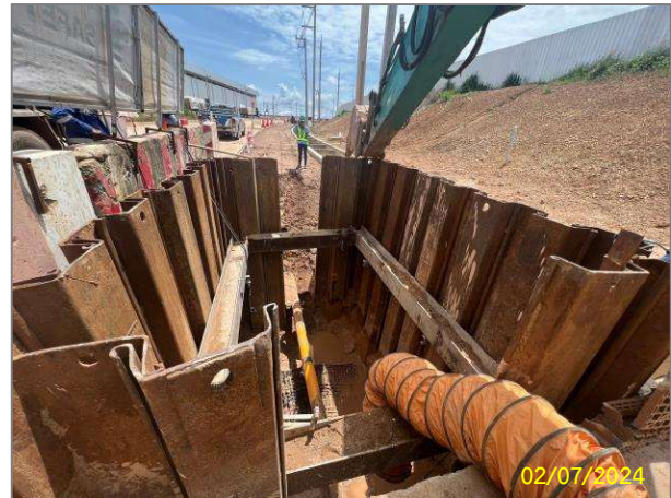
ก) การติดตั้ง Sheet Pile เพื่อป้องกันการถล่มของดิน
