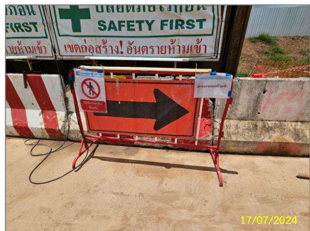
การกั้นเขตพื้นที่ก่อสร้าง พร้อมติดตั้งป้ายสัญญาณแสดงบริเวณที่ทำการชุด และเครื่องหมายเตือนแสดงเขตหวงห้ามที่อาจเกิดอันตราย ขณะรถแบ็คโฮกำลังปฏิบัติงาน
