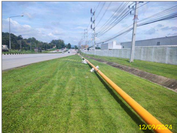
การจัดวางท่ออย่างเป็นระเบียบไม่กีดขวางการจราจร
