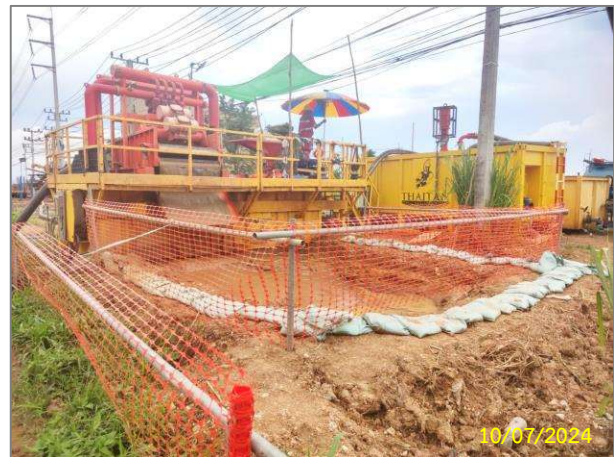
ค) การวางถุงทราย และจัดทำคันดินรอบพื้นที่บ่อรับ และบ่อส่ง
