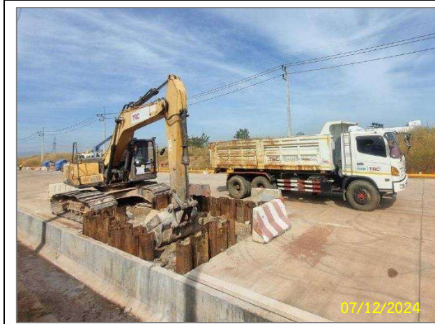
รูปที่ 2-3 ไม่เปิดหน้าดินพร้อมกันตลอดแนวก่อสร้าง
