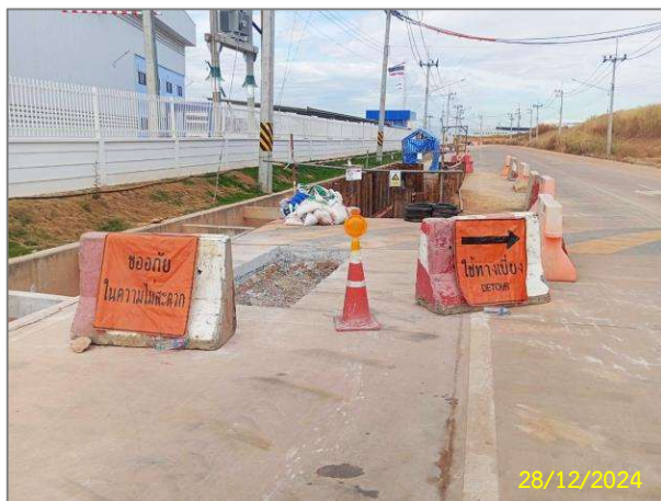
การจัดเตรียมเครื่องหมายจราจรในพื้นที่มีความเสี่ยงต่อการรั่วไหลของโคลนโซเดียมเบนทอนต์
