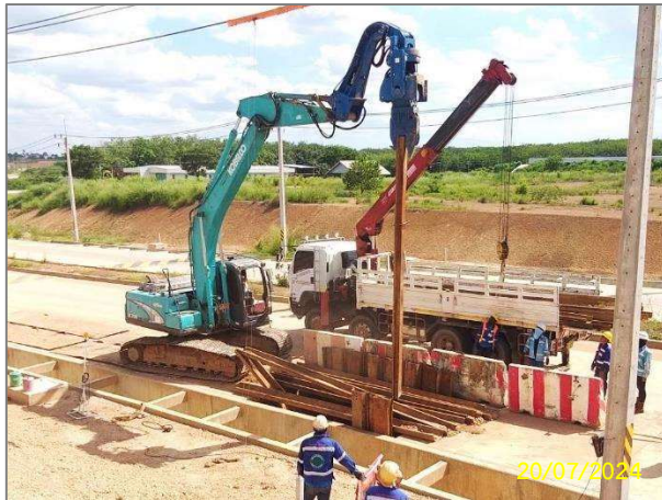
ก) การติดตั้ง Sheet Pile เพื่อป้องกันการถล่มของดิน
