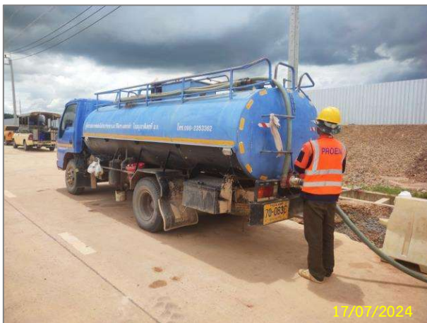
การจัดเตรียมรถดูด (Vacuum) สำหรับดูดโคลนโซเดียมเบนทอไนต์
