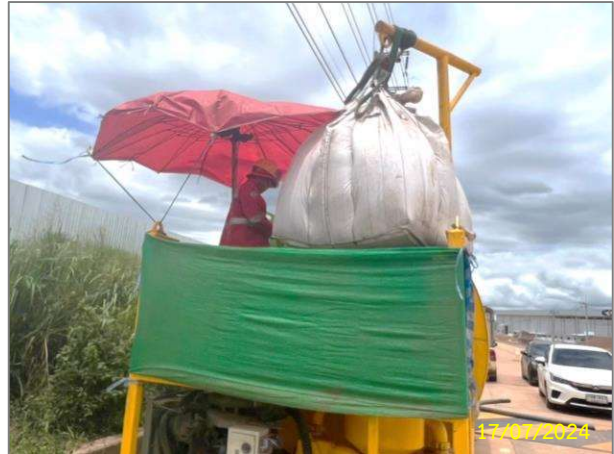
เจ้าหน้าที่ผสมโซเดียมเบนทอไนต์เพื่อใช้ในการเจาะลุดให้พอดีกับปริมาณงาน
