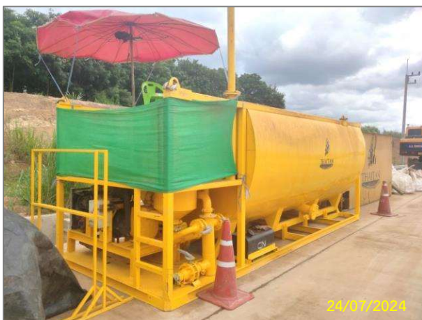
การกั้นพื้นที่ในขณะผสมโซเดียมเบนทอไนต์
