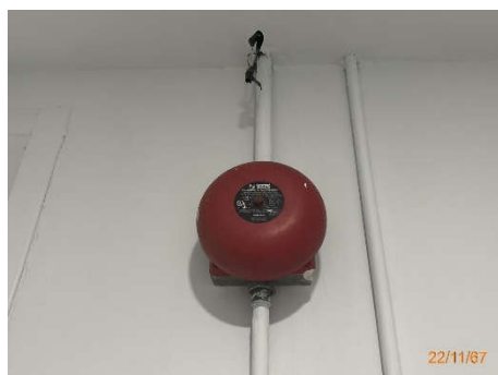
ภาพที่ 2.2-39 เครื่องแจ้งเหตุโดยใช้มือดึง (Fire Alarm Manual Station) และกริ่งสัญญาณเตือนภัย (Alarm Bell)
