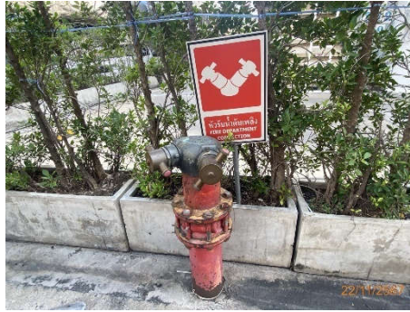
ภาพที่ 2.2-34 หัวรับน้ำดับเพลิง (Fire Department Connector : FDC)
