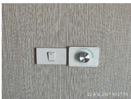
ภาพที่ 2.2-30 แยกสวิตช์ควบคุมอุปกรณ์ ไฟฟ้าแสงสว่าง
