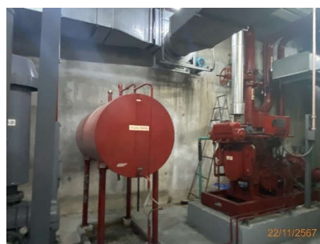
ภาพที่ 2.2-33 เครื่องสูบน้ำดับเพลิง (Fire Pump)
