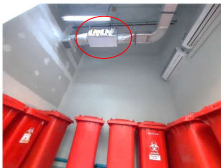
ภาพที่ 2.2-27 การติดตั้ง UV LAMP
