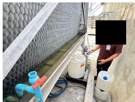
ภาพที่ 2.2-44 การเติมสารชีวฆาตในท่อฝังเย็น
