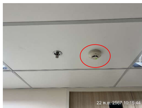
ภาพที่ 2.2-29 เครื่องตรวจจับควัน (Smoke Detector)
