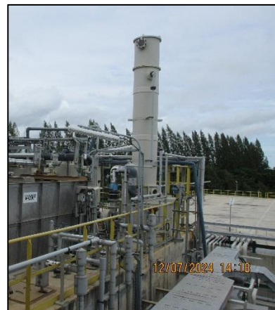
ภาพที่ 2-15 หน่วยบำบัดกลิ่นแบบสครับเบอร์ จำนวน 2 ชุด
