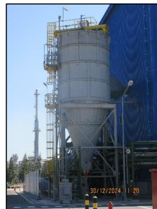
ภาพที่ 2-4 เครื่องดักฝุ่นแบบ Bag Filter
