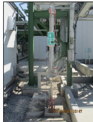
ภาพที่ 2-29 อ่างล้างตาและร่างกายฉุกเฉิน
