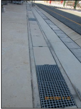
ภาพที่ 2-17 รางระบายน้ำในพื้นที่โครงการ
