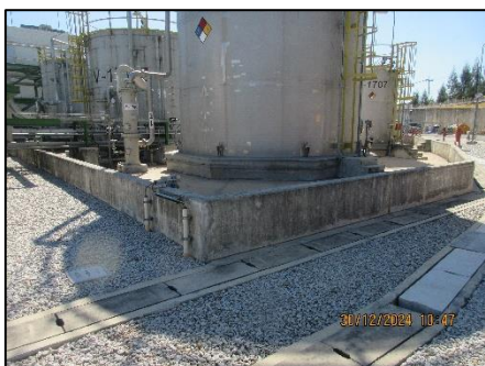
ภาพที่ 2-33 คันกันคอนกรีตล้อมรอบลานถังเก็บกัก
