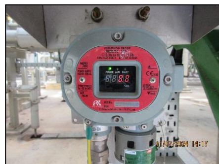
ภาพที่ 2-8 Gas Detector
