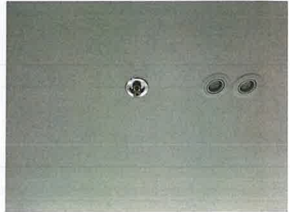
รูปที่ 2-32 ระบบหัวกระจายน้ำดับเพลิงอัตโนมัติ
