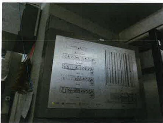
รูปที่ 2-35 แผงควบคุม (Fire Alarm Control Panel : FCP)
