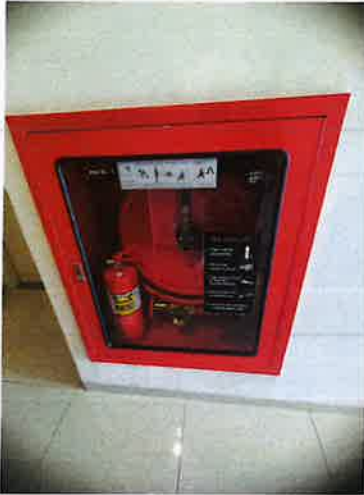
รูปที่ 2-31 เก็บสายฉีดน้ำดับเพลิงพร้อมอุปกรณ์
