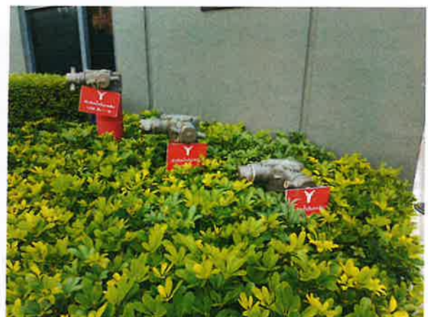
รูปที่ 2-30 หัวรับน้ำดับเพลิงภายนอกอาคาร
