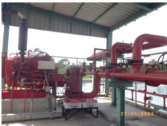
ระบบจ่ายน้ำดับเพลิง (Fire Water Supply)
