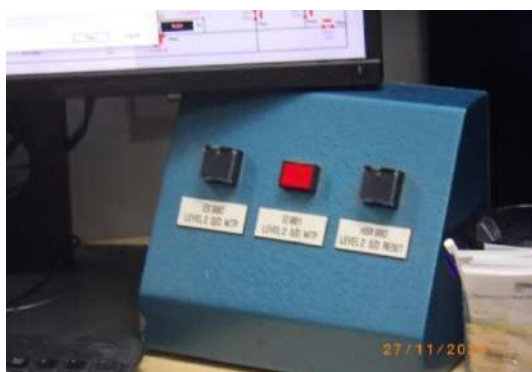
ระบบหยุดปั๊มอัตโนมัติ สถานีสูบน้ำดิบมาบตาพุด
