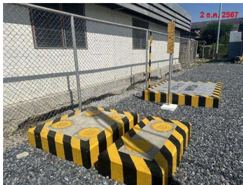
ภาพที่ 2.2-4 วาล์วควบคุมแรงดัน และระบบวาล์วใต้ดิน
