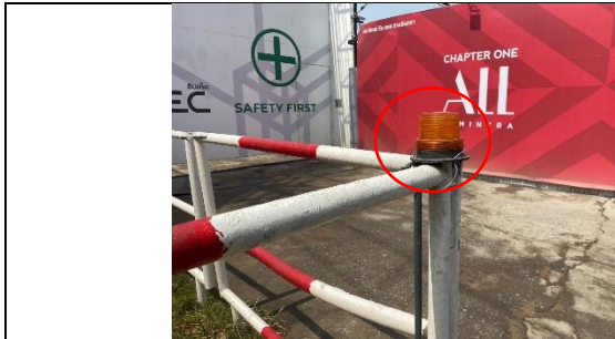
รูปที่ ๗.๔๙ สัญญาณไฟเตือน ไฟกระพริบ ในระยะก่อสร้าง
