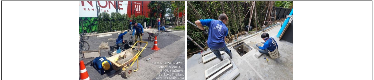
รูปที่ ผ7.82 การขุดลอกตะกอนดินทรายที่อาจตกค้างในรางระบายน้ำหลังก่อสร้างแล้วเสร็จ
